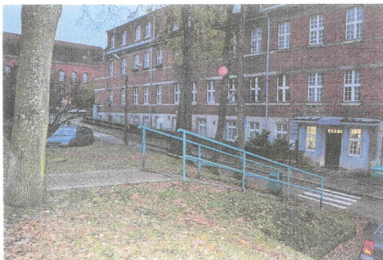
Zdj. 2. Schody terenowe przed budynkiem WGIPIB przy ul. Prawocheńskiego 15 w Olsztynie.
