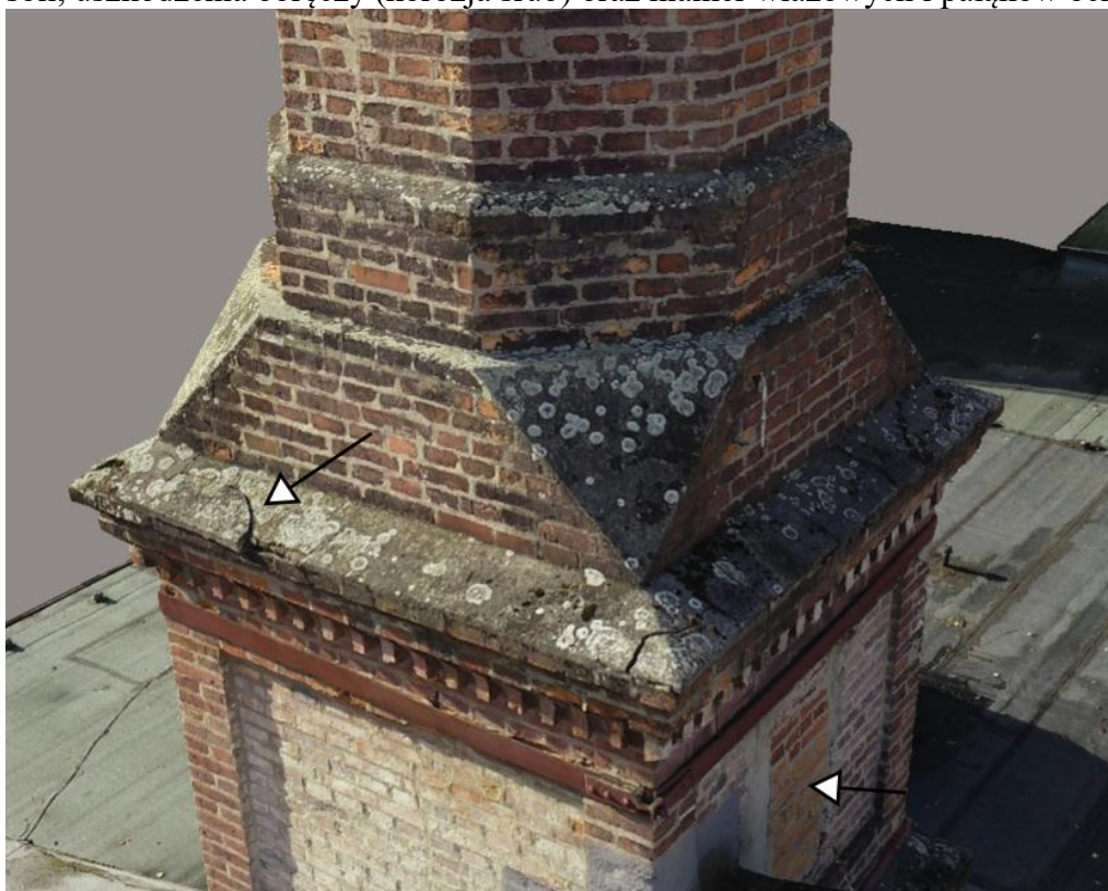
Fot 4. Cokół komina ponad dachem, widoczne uszkodzenia gzymsów, lokalne złuszczenia powierzchni cegieł oraz biologiczne narosty, a także zamurowany otwór rewizyjny.
