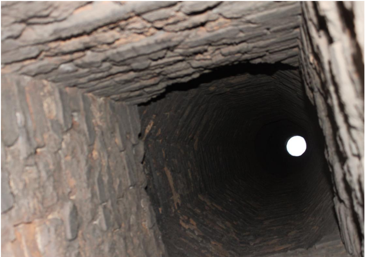
Fot 7. Przewód dymowy komina na styku trzonu kwadratowego i ośmiobocznego.
