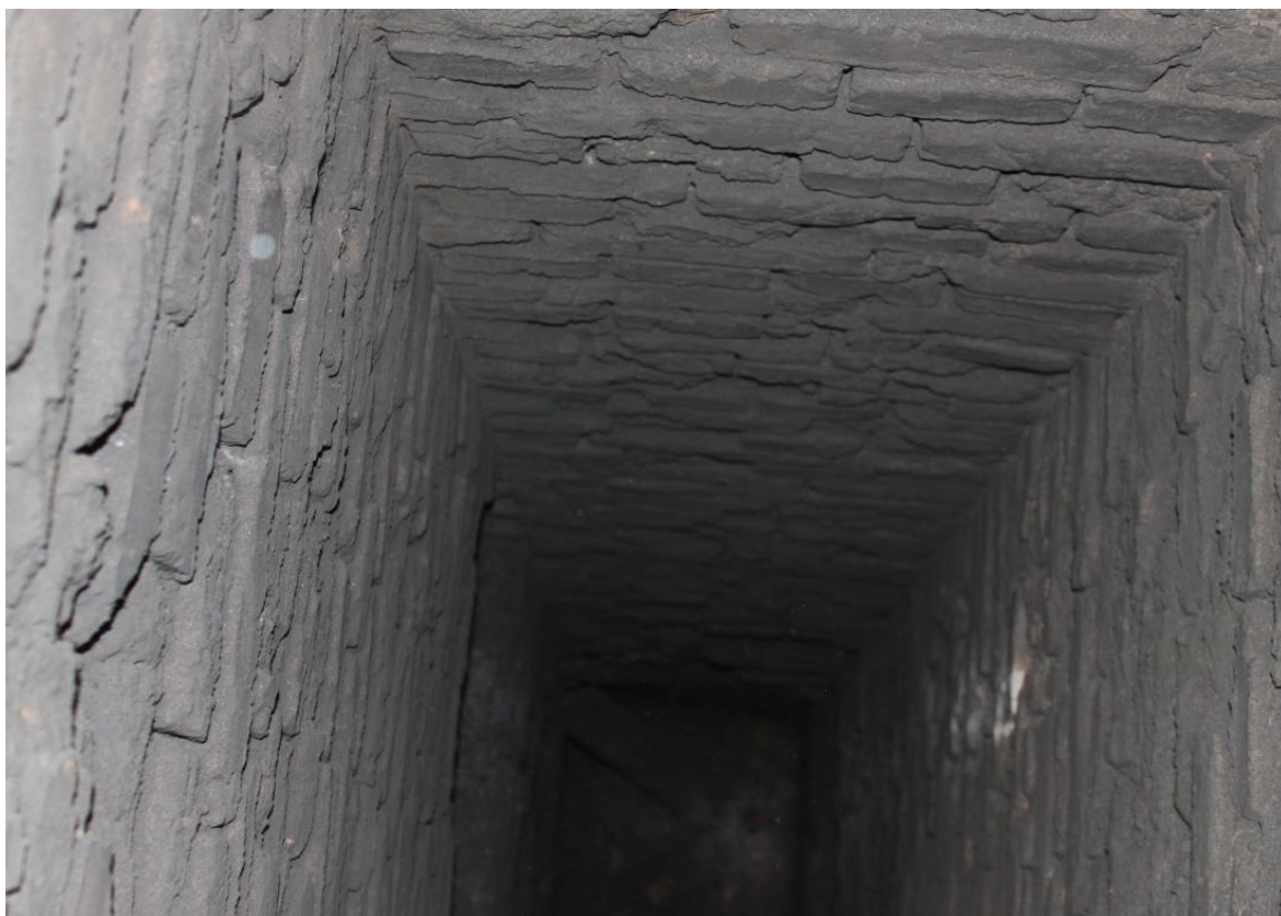
Fot 9. Przewód dymowy komina od otworu rewizyjnego w dół.
