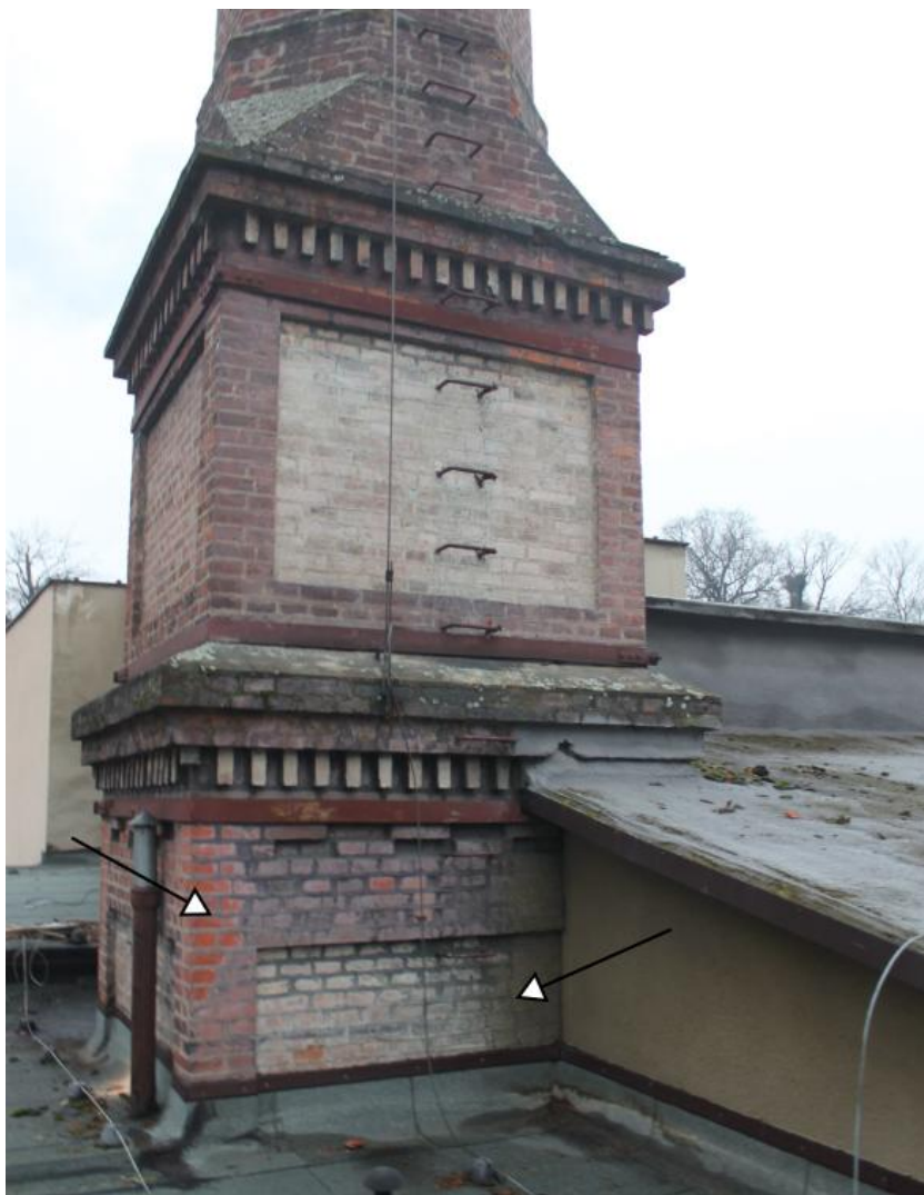
Fot 5. Cokół komina ponad dachem, widoczne wtórne przemalowana elewacji, pęknięcie muru oraz naprawy (przemurowanie).
