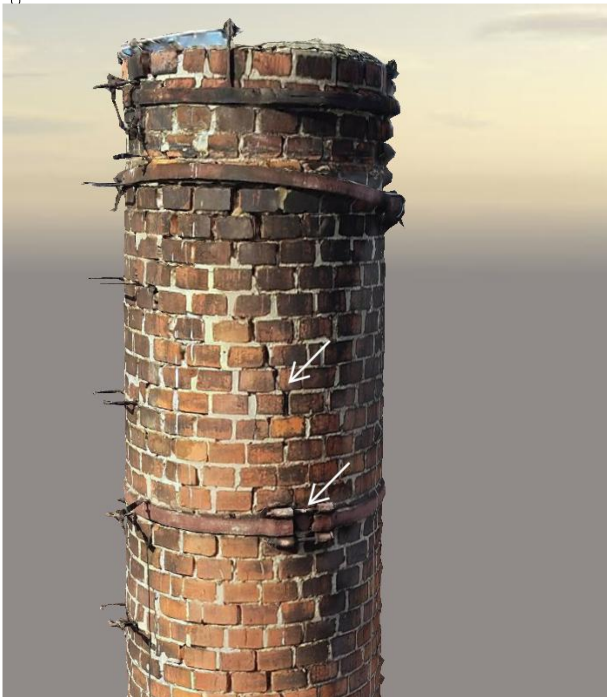
Fot 2. Wierchołek komina, widoczne pęknięcia muru, uszkodzenia obręczy (korozja śrub) oraz klamer włazowych i instalacji odgromowej.
