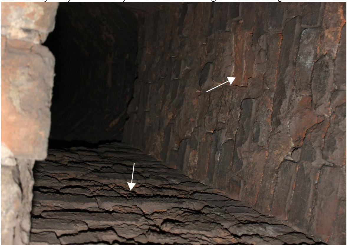
Fot 8. Przewód dymowy komina na styku trzonu kwadratowego i ośmiobocznego widoczne ubytki cegły.
