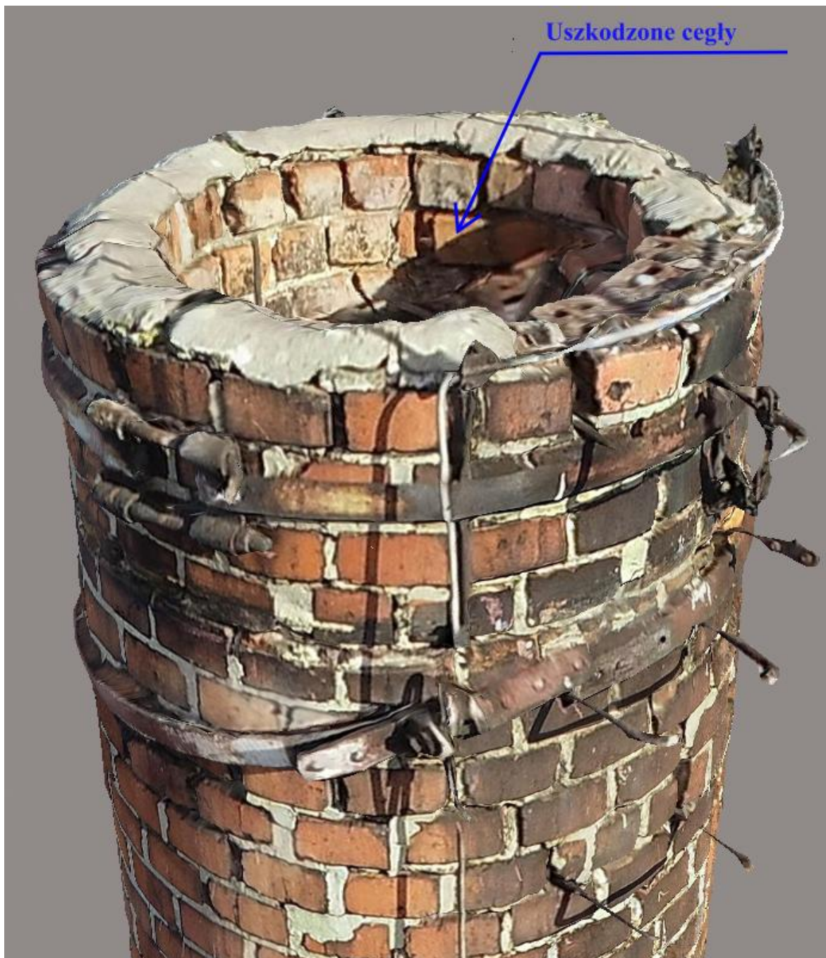
Fot 1. Wierzchołek komina, widoczne uszkodzenia muru i zaprawy w spoinach, uszkodzenia obręczy (obręcz starsza i nowsza) oraz klamer włazowych i instalacji odgromowej.
