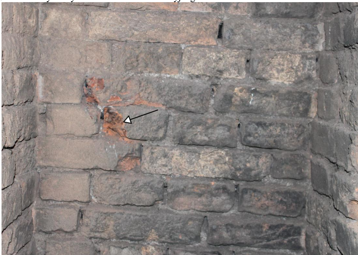
Fot 10. Przewód dymowy komina na wysokości otworu rewizyjnego. Odkucie badawcze fragmentu cegły.
