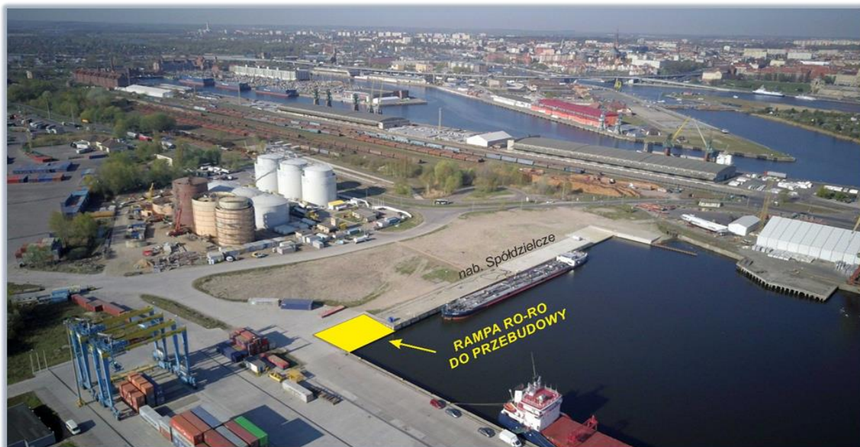
Zdj. Nr 1 Lokalizacja rampy ro-ro, przeznaczonej do przebudowy.
