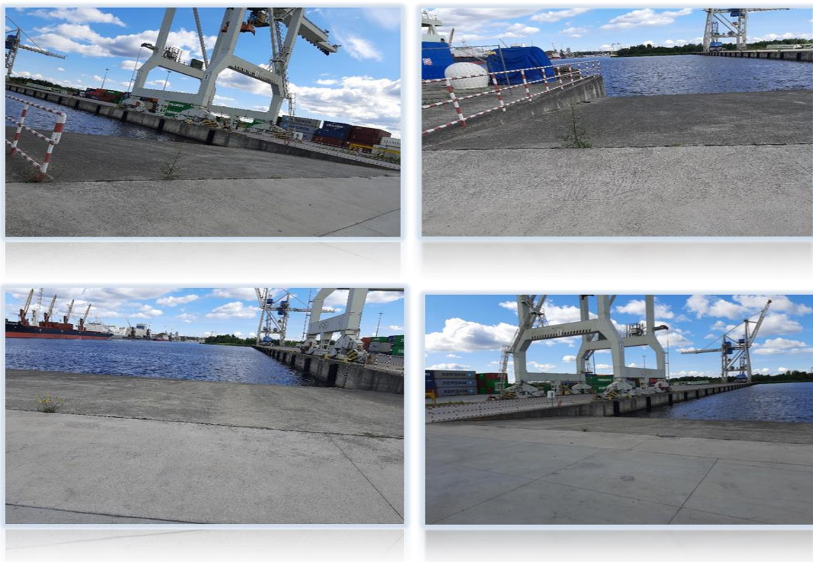
Zdj. Nr 2 Rampa ro-ro, przeznaczonej do przebudowy.
