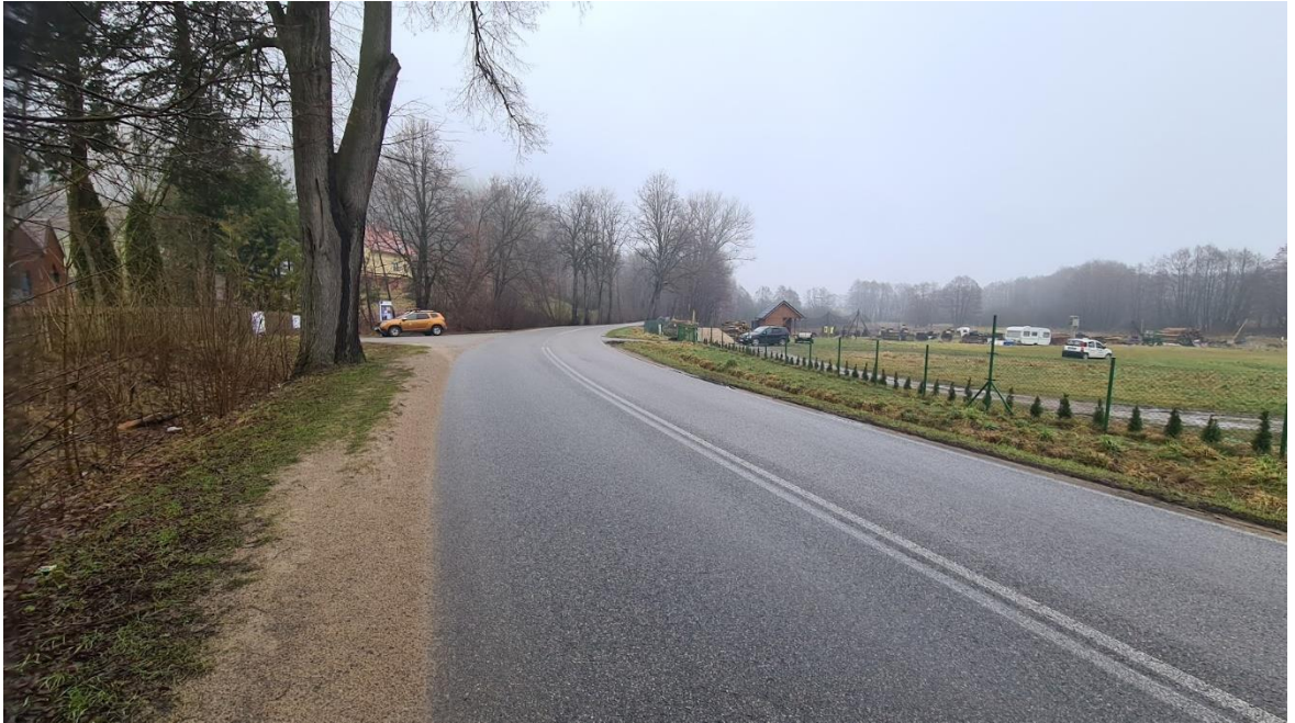
Fot. nr 1. Prawa strona drogi widok z kierunku Brodnicy Górnej w oddali skrzyżowanie z drogą gminną G115920G do Grzebieńca (początek planowanej inwestycji).
