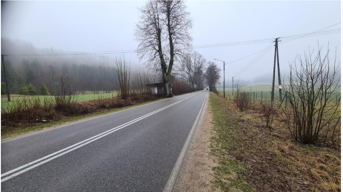
Fot. nr 3. Prawa strona drogi widok z kierunku Ręboszewa – lokalizacja istniejących przystanków autobusowych.
