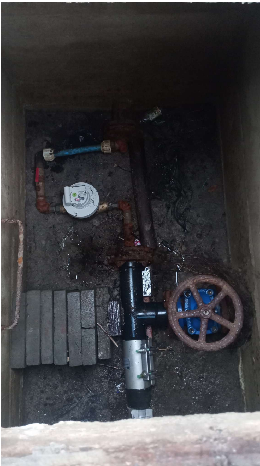
Rysunek 1 – widok komory wodomierzowej przed bramą główną szkoły
