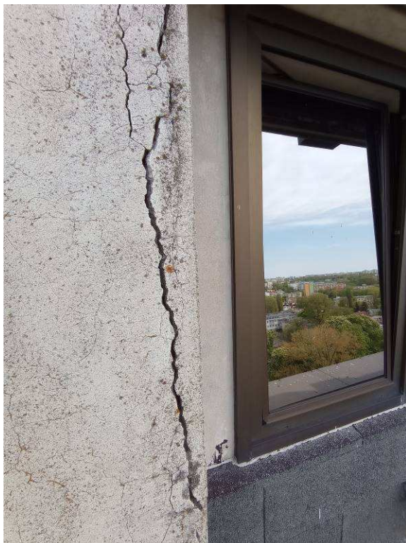
Fot. autor. Stan obecny elewacji (korozja biologiczna ścian i ubytki tynku)
