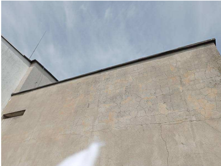
Fot. autor. Stan obecny elewacji (spękania powierzchni tynku)
