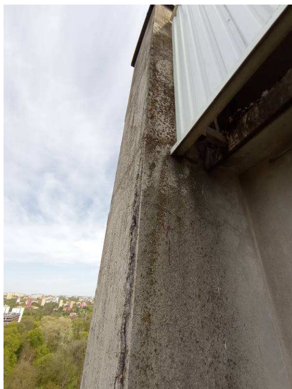
Fot. autor. Stan obecny elewacji (korozja biologiczna ścian i ubytki tynku)
