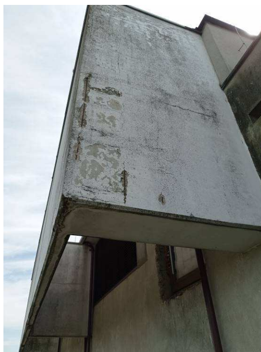
Fot. autor. Stan obecny elewacji (odsłonięte fragmenty zbrojenia)
