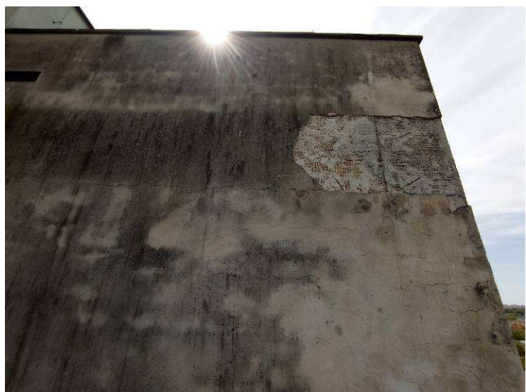
Fot. autor. Stan obecny elewacji (korozja biologiczna ścian i ubytki tynku)
