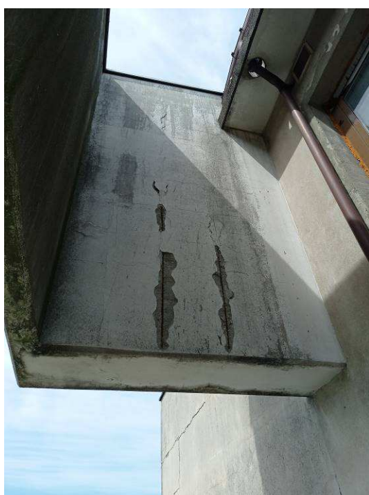
Fot. autor. Stan obecny elewacji (odsłonięte fragmenty zbrojenia)
