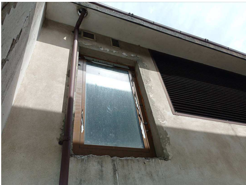
Fot. autor. Stan obecny elewacji (brak parapetu)
