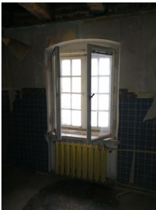
Zdjęcie 5. Okno na poddaszu od strony podwórka.
