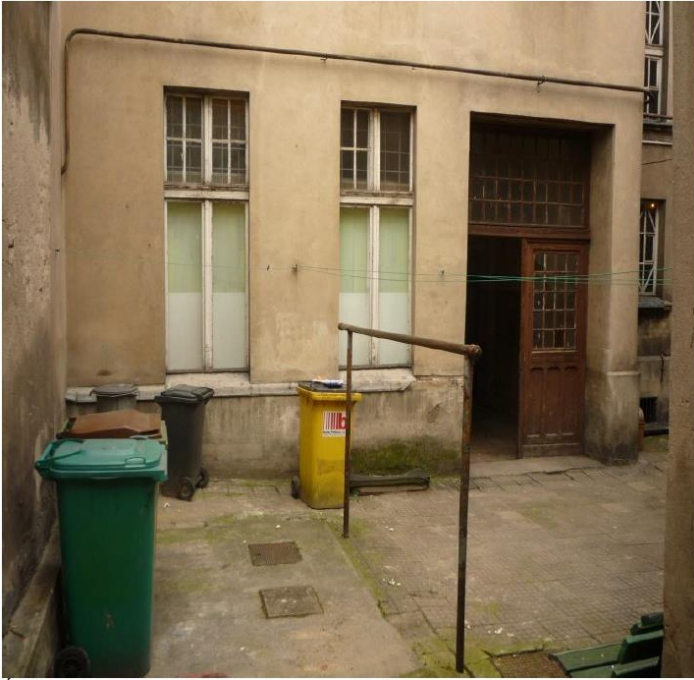
Zdjęcie 6. ( z dokumentacji od firmy Atrium Studio Pracownia Projektowa): Okna od podwórka na parterze.
