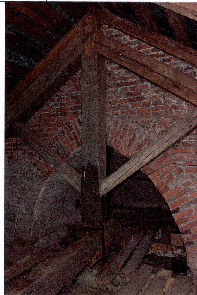
18. Fragment wieżby dachowej przy wieży.
