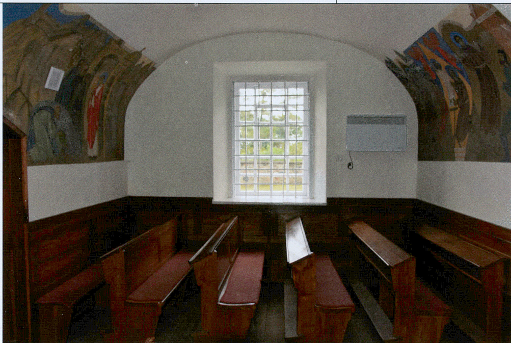
15. Sklepienie kolebkowe w dawnej zakrystii, obecnie kaplicy św. Antoniego.
