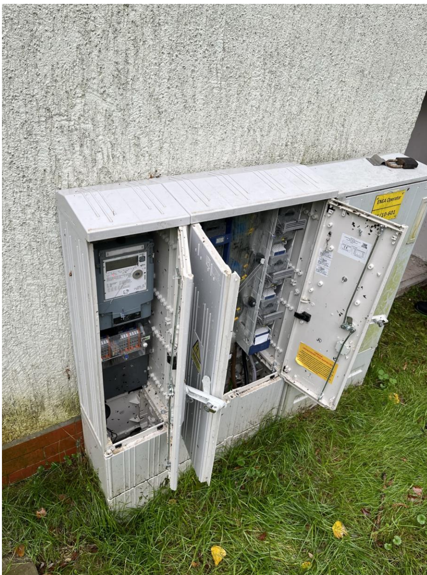
Rys. 3 Złącze kablowe z licznikiem dla PPE 590310600031277626
