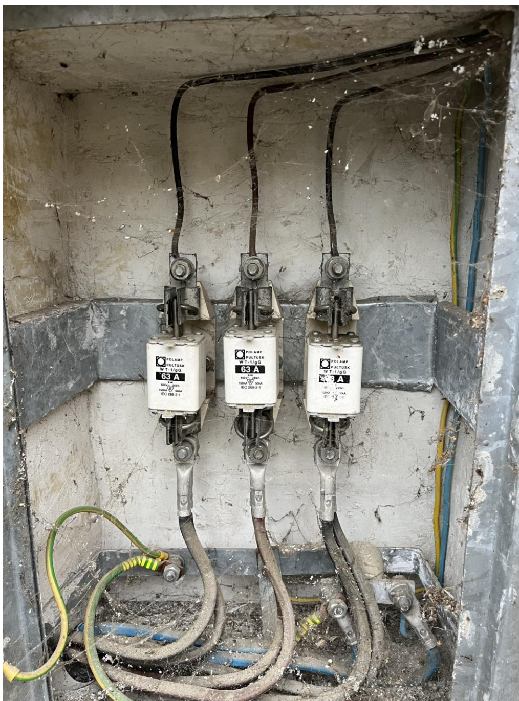
Rys. 6 Widok stanu istniejącego złącza kablowego lokalu mieszkalnego
