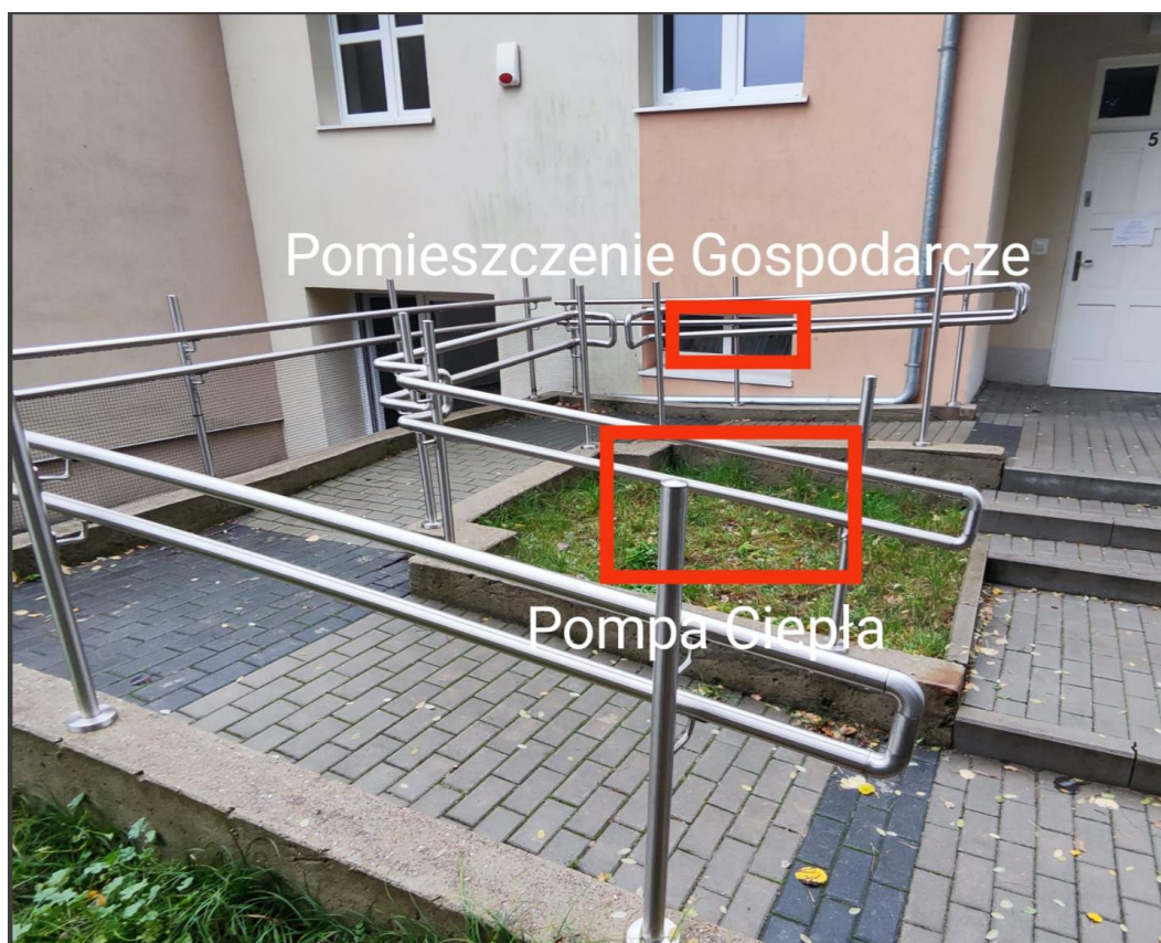
Rys. 2 Wejście do pomieszczeń piwnicznych, widok pom. gospodarczego oraz wskazanie lokalizacji PC
