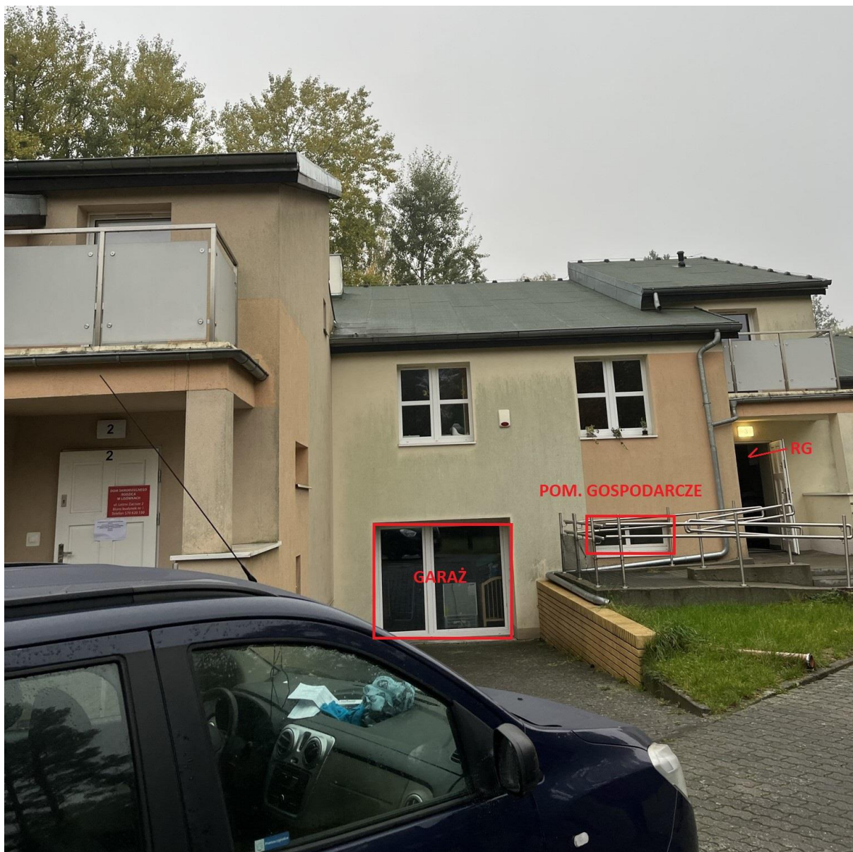
Rys. 2 Wejście do pomieszczeń piwnicznych, widok pom. gospodarczego oraz wskazanie lokalizacji rozdzielnic głównej
