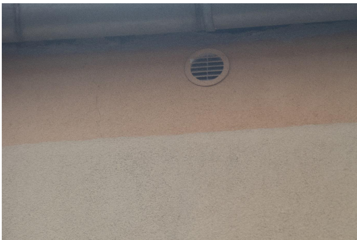
Fot. 5. Ściana D – kratki w otworach stropodachu.
