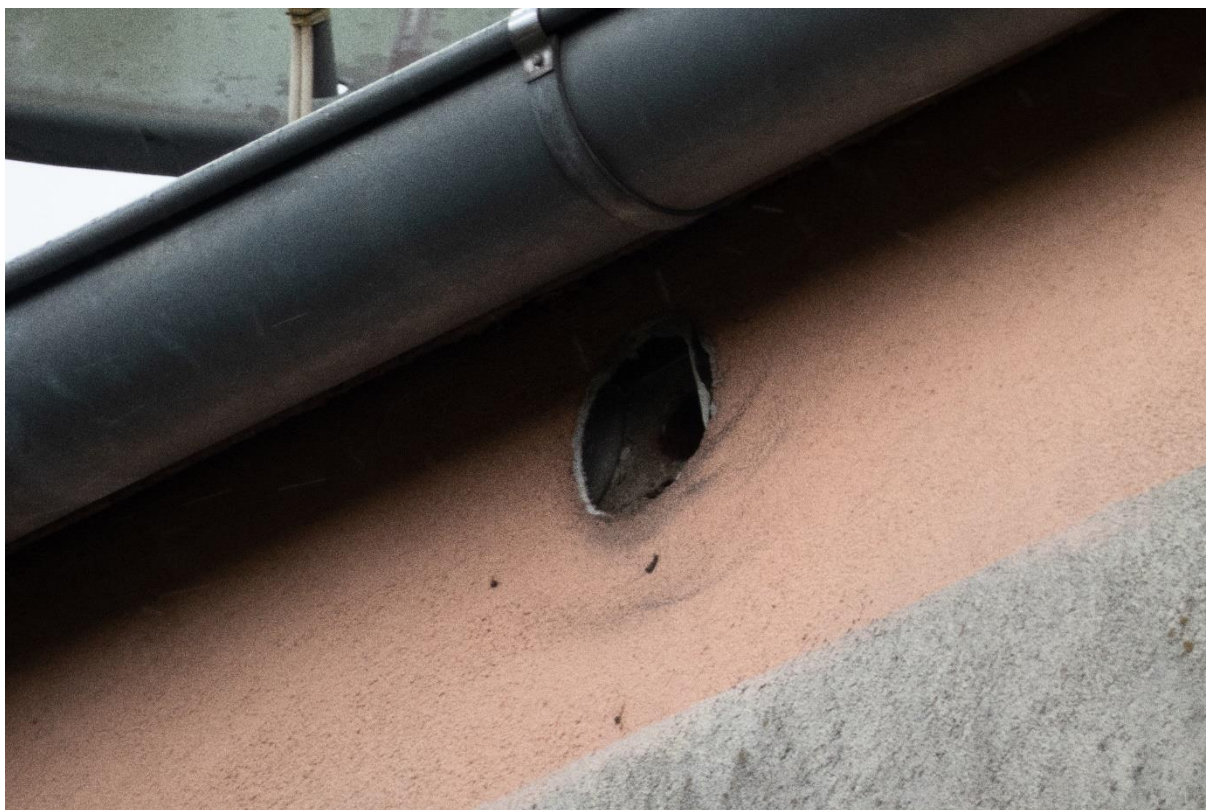
Fot. 14. Stropodach (ściana A) – wejście do gniazda kawek.
