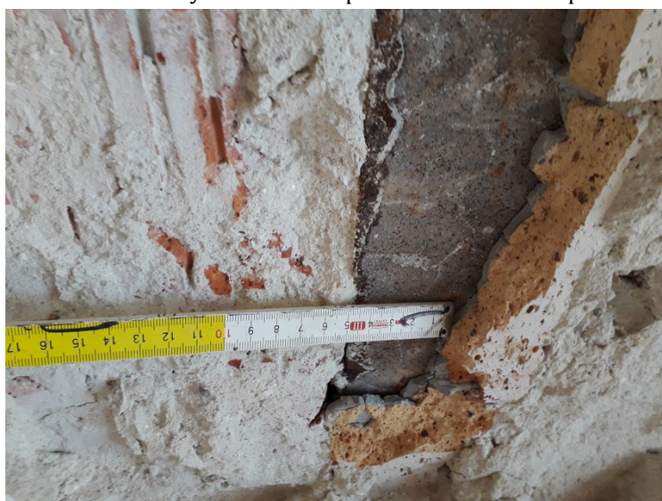
Ryc.27 Pole 7 – stopka dolna belki zabezpieczona kształtką ceramiczną
