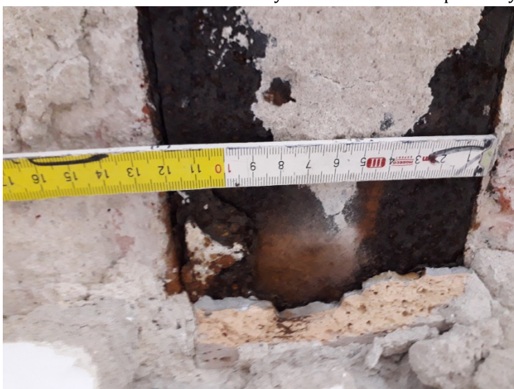
Ryc.19 Pole 3 – stopka dolna belki skorodowana (w rejonie oparcia na murze – ściana zewnętrzna)
