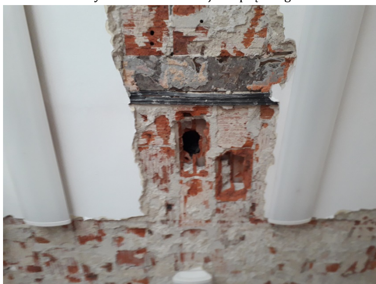
Ryc.15 Pole 2 – rozkute od dołu kształtki ceramiczne płyty stropu
