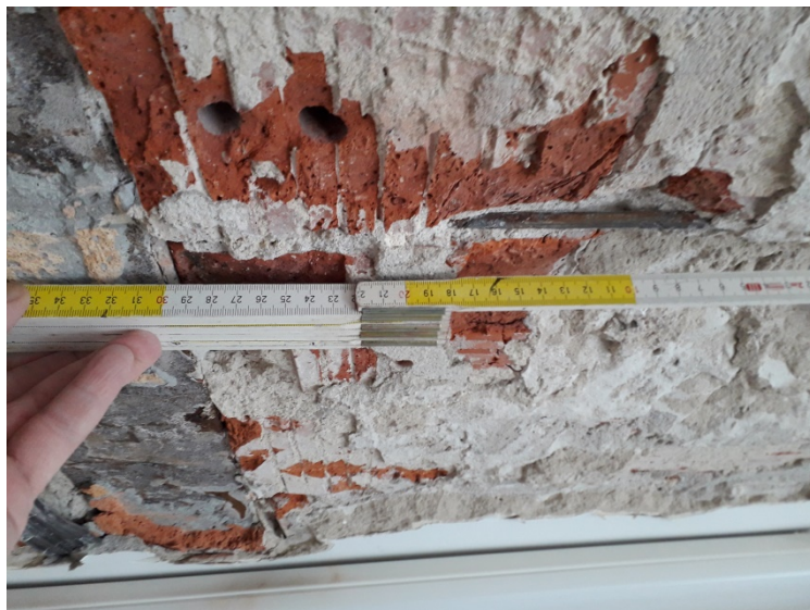
Ryc.14 Pole 2 – zbrojenie prętem gładkim d=8\text{mm}
