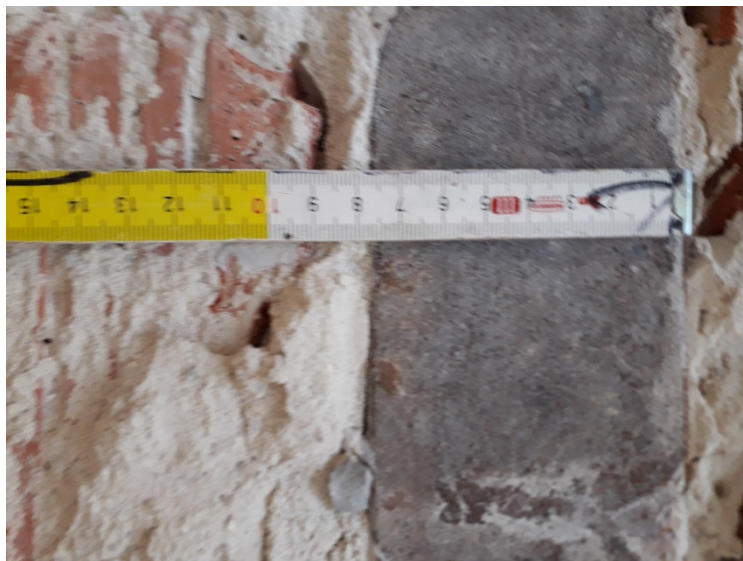
Ryc.26 Pole 7 – pomiar szerokości stopki dolnej
