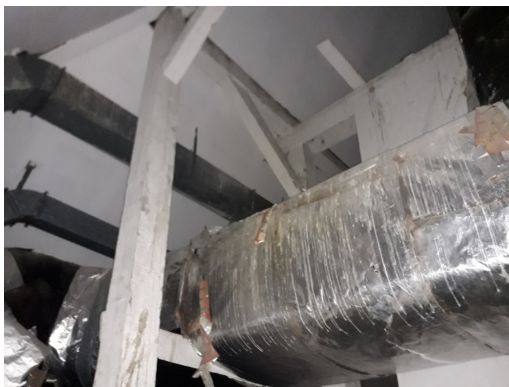
Ryc.28 Strych zabudowany kanałami wentylacyjnymi
