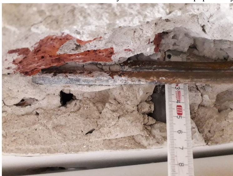
Ryc.13 Pole 2 – zbrojenie prętami gładkimi 2 x d=8mm
