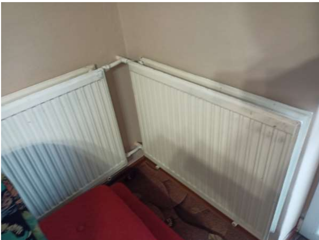
Rysunek 2 Zakres modernizacji – montaż termostatów do istniejących grzejników
