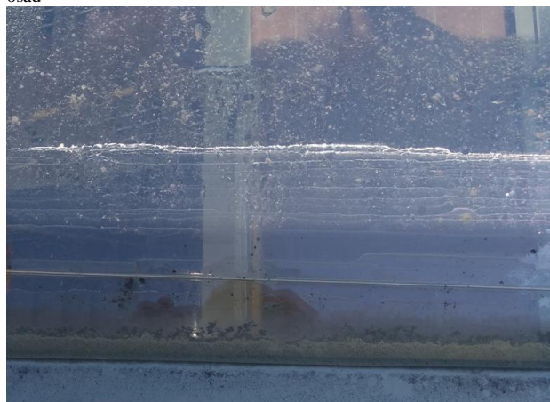
fot.1.10 Widoczna kraw d wody w przestrzeni mi dzyszybowej oraz osad
