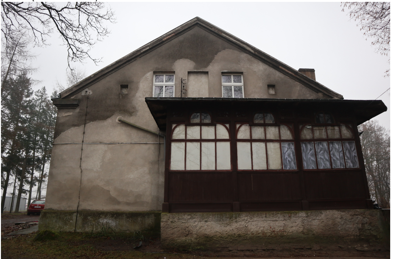
Fot. 13. Elewacja szczytowa północno-zachodnia dawnego dworku w Gałczewku z secesyjną werandą.
