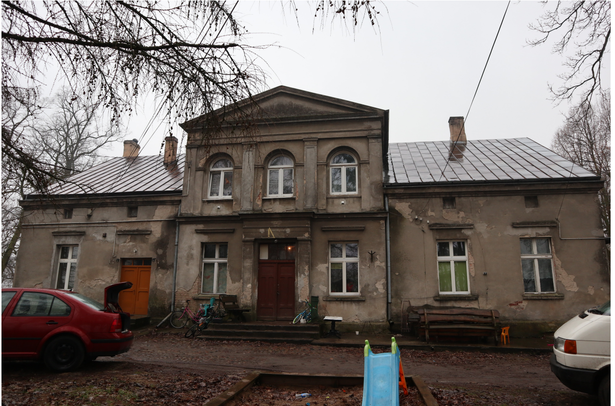
Fot. 1. Elewacja frontowa, północno-wschodnia dawnego dworku w Gałczewku.
