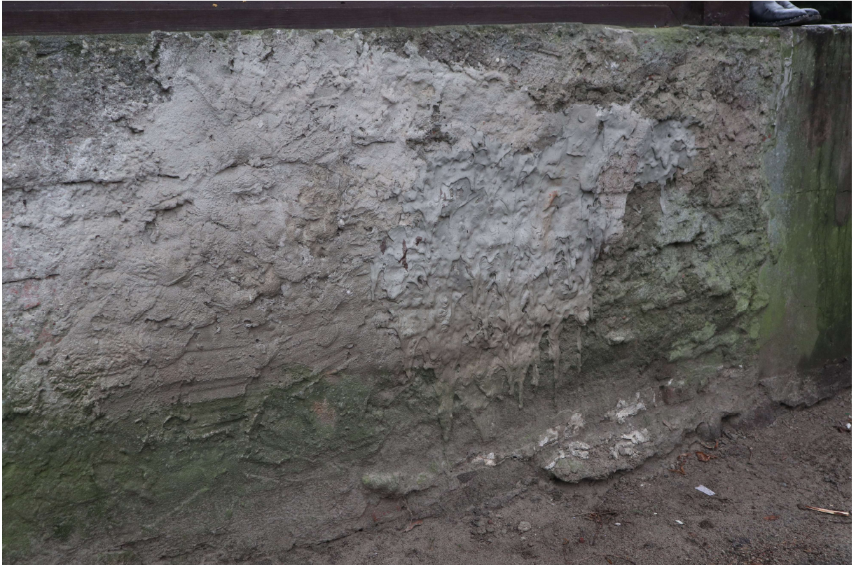
Fot. 41. Weranda. Zbliżenie na mурowany cokół-taras z widocznymi wtórnymi założonymi zaprawami, zachlapaniami. Widoczne porażenie biologiczne.
