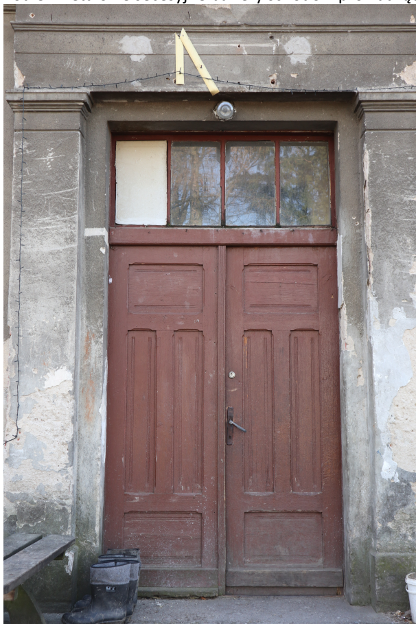
Fot. 6. Elewacja frontowa, północno-wschodnia dawnego dworku w Gałczewku. Drzwi w portalu gł.
