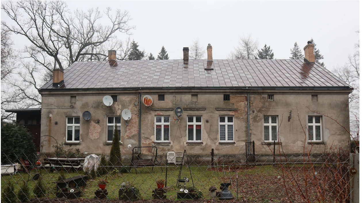
Fot. 8. Elewacja tylna, południowo-zachodnia dawnego dworku w Gałczewku.
