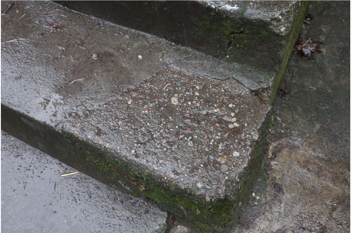
Fot. 63. Schody prowadzące do portalu gł. Widoczne wtórne uzupełnienia ubytków, drobne ubytki i mszaki. Na stopniach.
