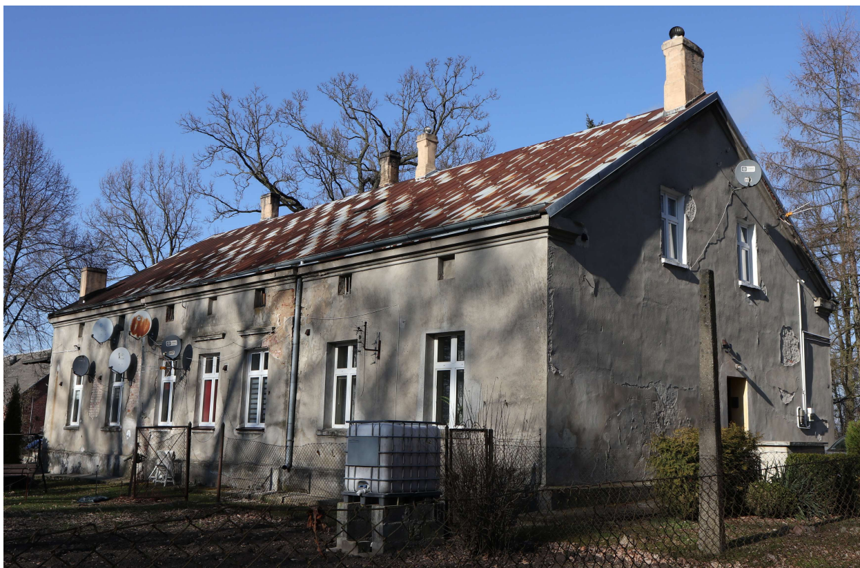
Fot. 10. Widok na elewację tylną i szczytową południowo-wschodnią dawnego dworku w Gałczewku.
