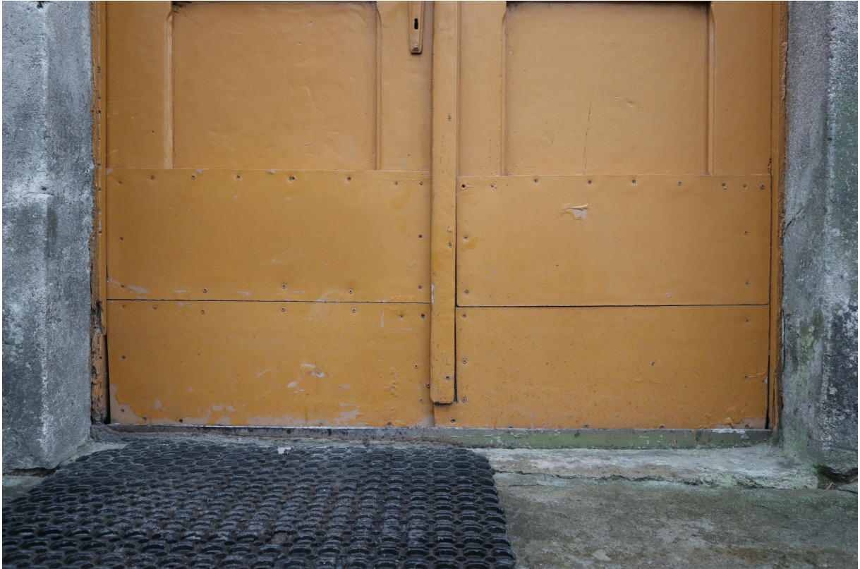
Fot. 56. Drzwi boczne (po 1982 r.). Widoczne wtórne obicie płytą blachą ochronną.
