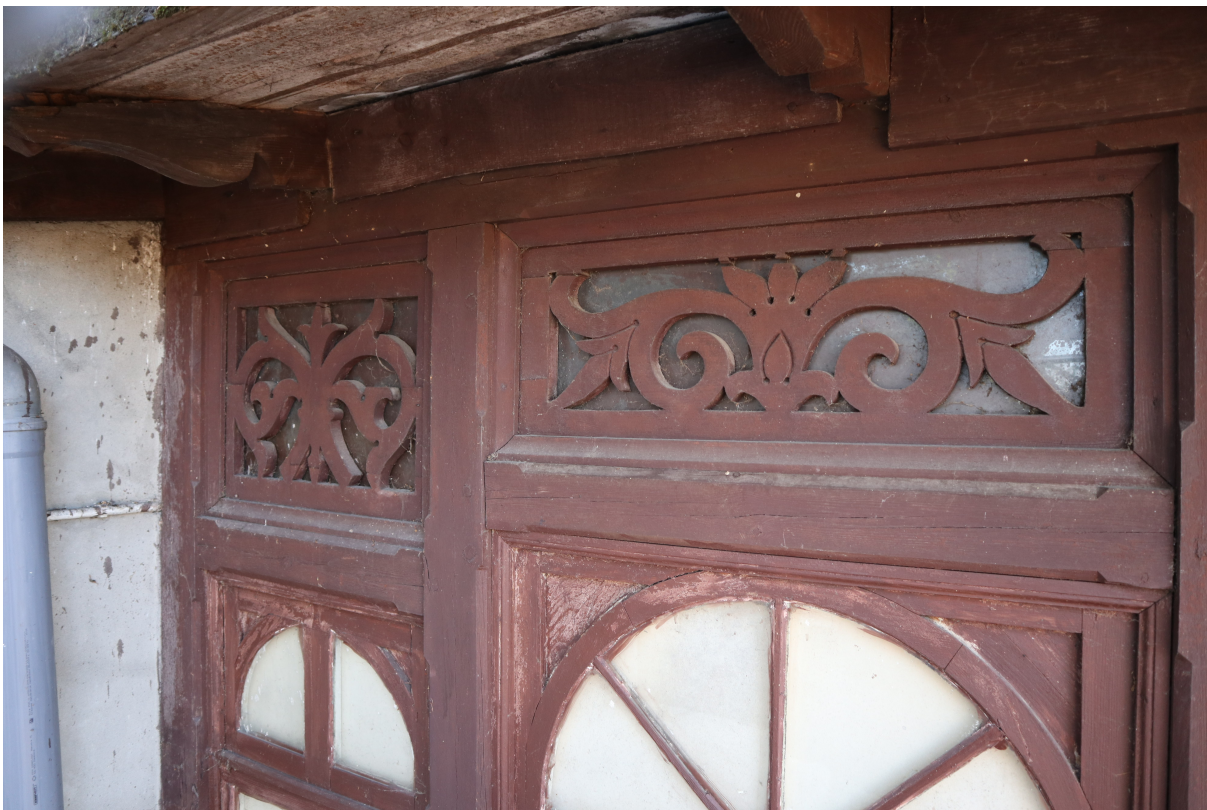
Fot. 45. Weranda. Fragment górnej strefy ściany północno-wschodniej z widocznymi oryginalnymi ażurowymi płycinami i przeszkleniami.
