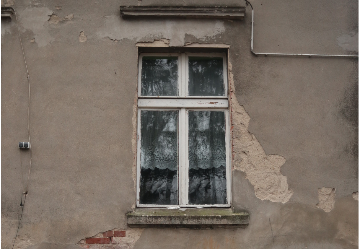
Fot. 59. Elewacja frontowa. Wtórna drewniana stolarka okienna.
