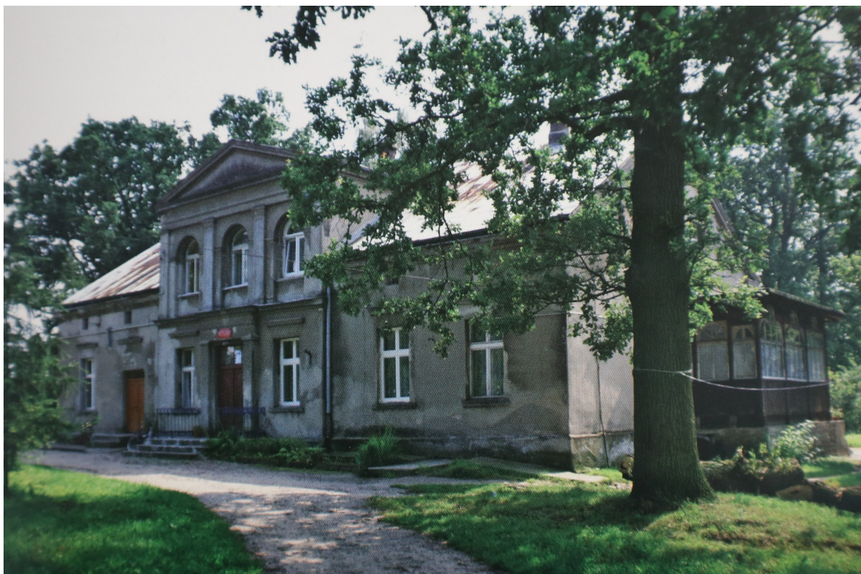
Ryc. 7. Dwór w Gałczewku, elewacja północna i fragment zachodniej z werandą [w:] R. Kowalski, Gmina Golub-Dobrzyń. Historia, zabytki, krajobraz , Golub-Dobrzyń 2010 r., s. 61.
