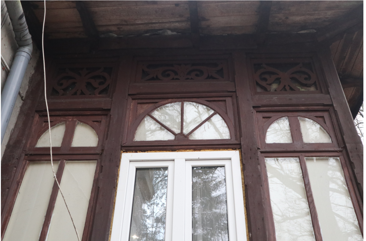
Fot.16. Secesyjna drewniana weranda. Widok na przeszklenia i dekoracyjne płyciny w ścianie północno-zachodniej.
