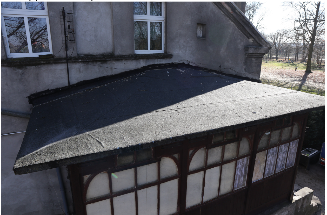
Fot. 15. Secesyjna drewniana weranda posadowiona na murowanej podmurówce. Widok na dach werandy.
