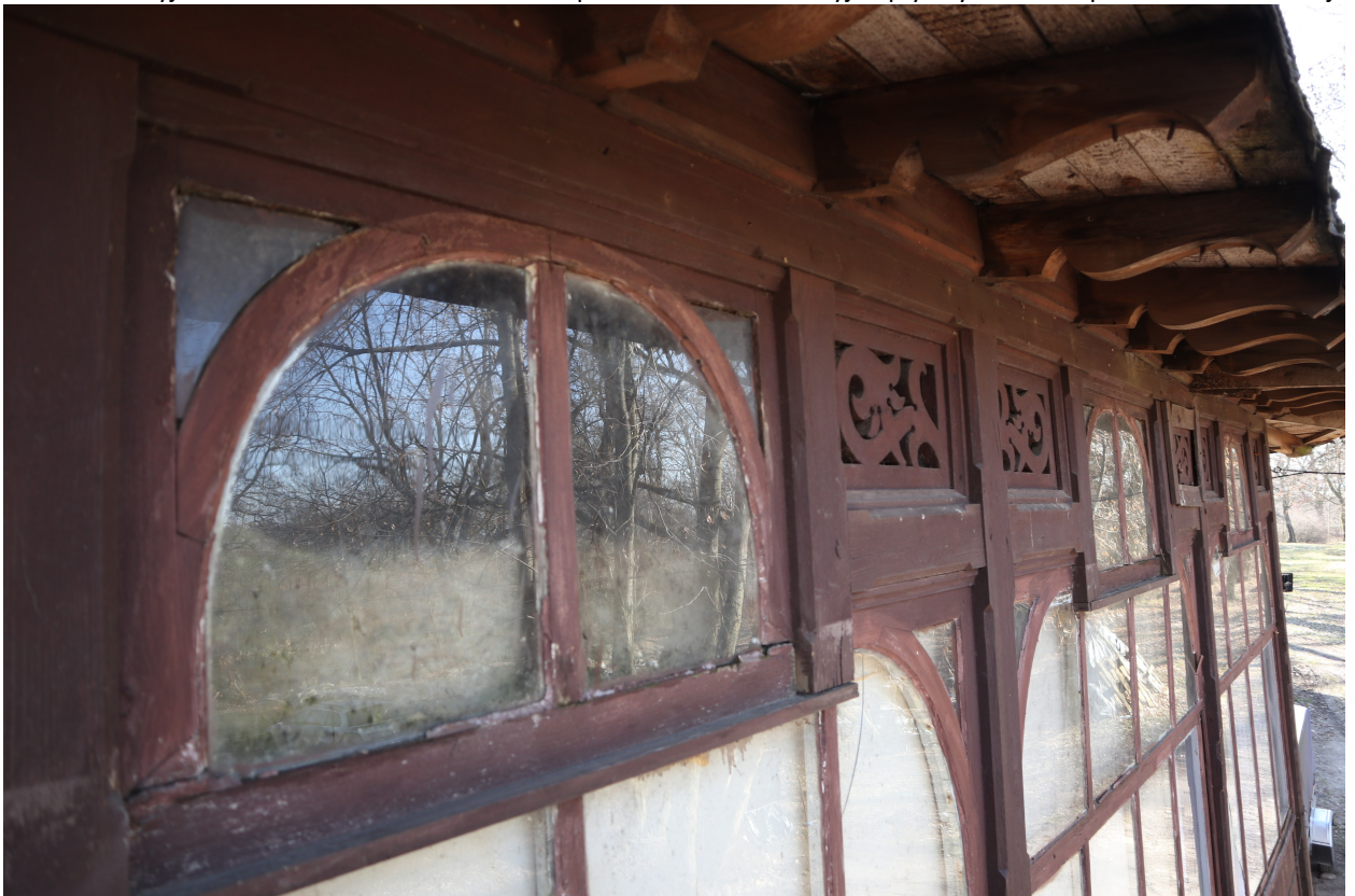
Fot. 17. Secesyjna drewniana weranda. Widok na przeszklenia, dekoracyjne płyciny i końcówki kroki w ścianie północno-wschodniej.
