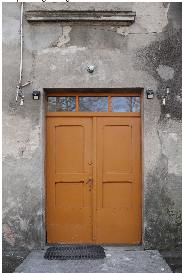
Fot. 7. Elewacja frontowa, północno-wschodnia dawnego dworku w Gałczewku. Drzwi boczne w 2.osi od wsch.
