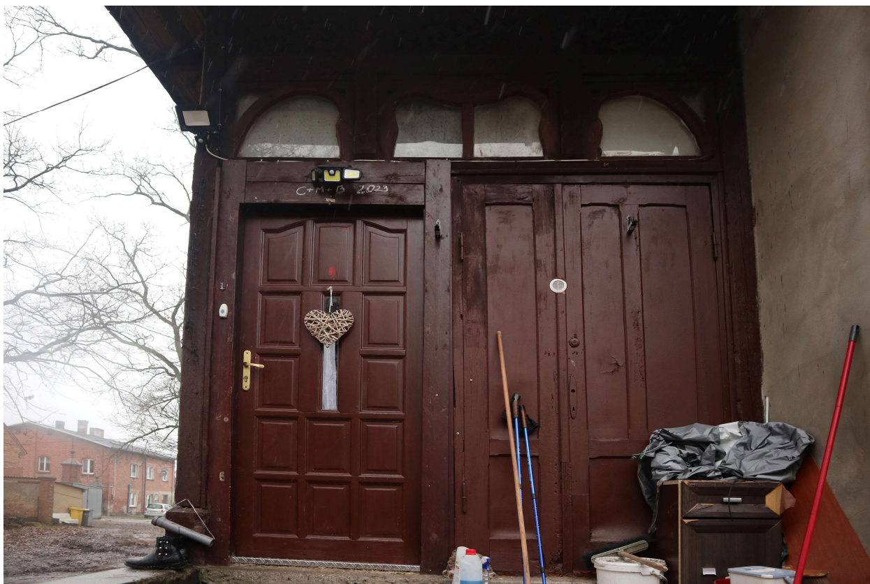
Fot. 18. Secesyjna drewniana weranda. Ściana południowo-zachodnia z wtórną stolarką drzwiową.
