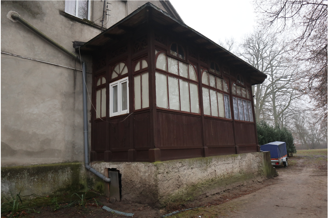
Fot. 14. Secesyjna drewniana weranda posadowiona na murowanej podmurówce. Widok na ścianę północno-wschodnią i północno-zachodnią.
