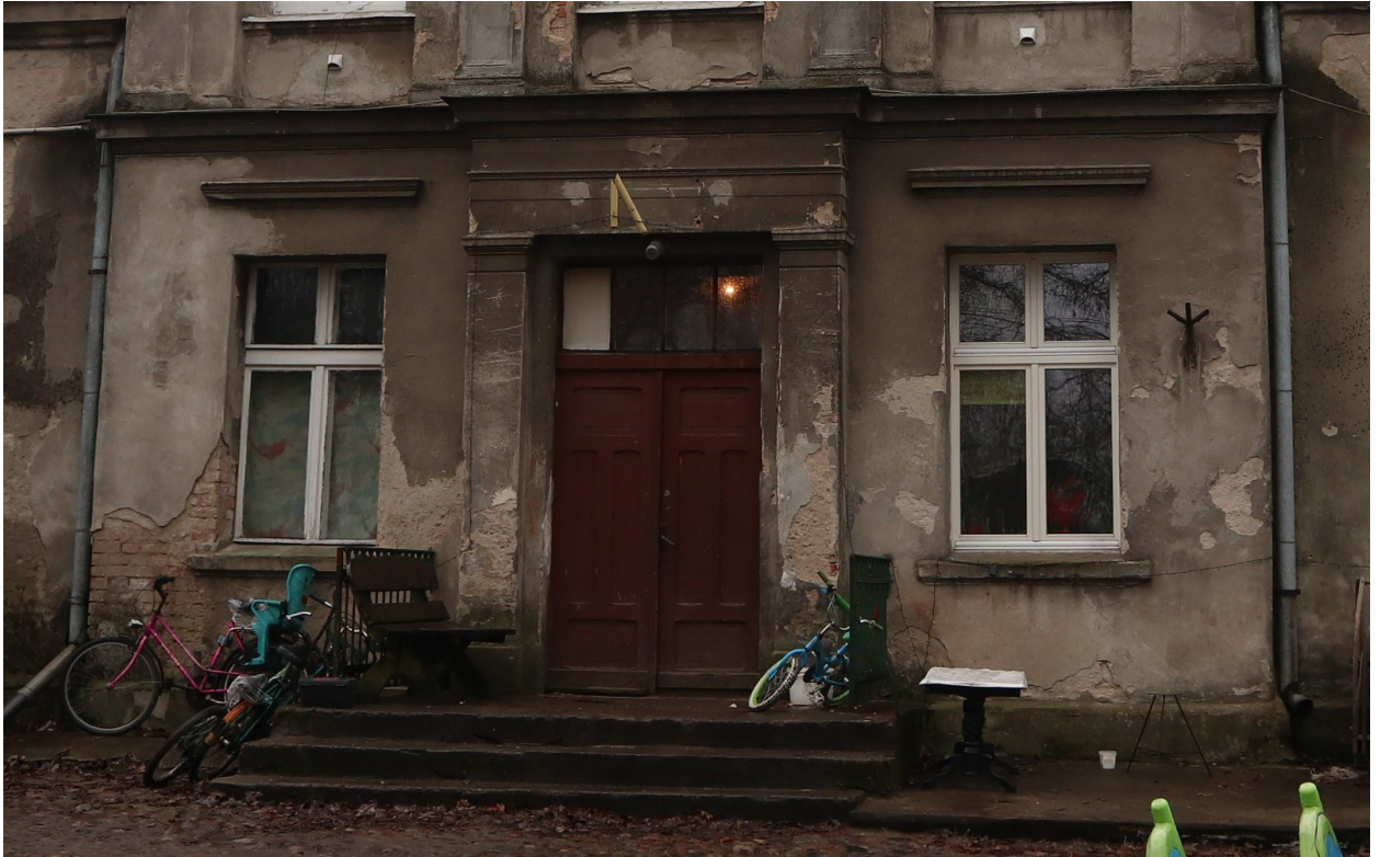
Fot. 3. Elewacja frontowa, północno-wschodnia dawnego dworku w Gałczewku. Portal gł. w pseudoryzalicie.
