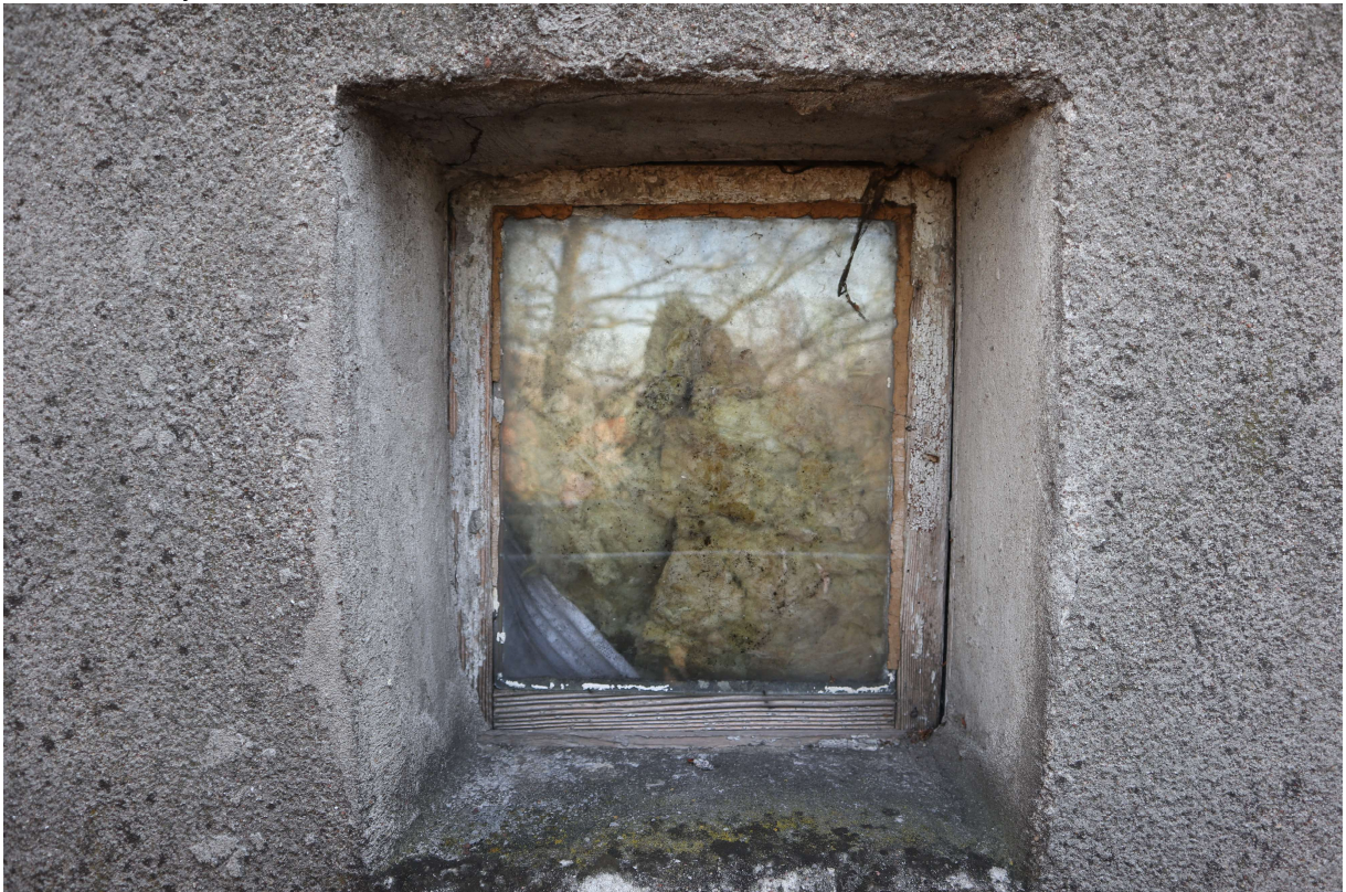
Fot. 60. Elewacja szczytowa północno-zachodnia. Historyczna stolarka okienna poddasza.
