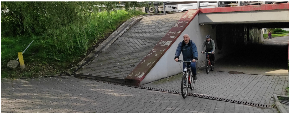
Rys. 26 Istniejący obiekt inżynierski: Tunel pod drogą DK 81 w rejonie ul. Bielskiej.
