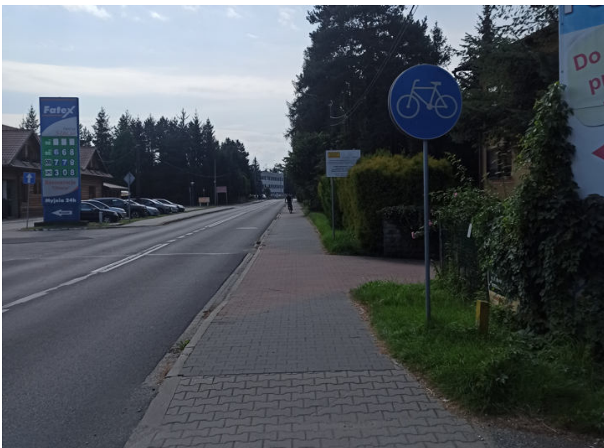
Rys. 12 Istniejąca droga dla rowerów w ciągu ul. Górny Bór. Ciąg nie spełnia parametrów technicznych zgodnych z obowiązującymi przepisami 16 w zakresie nawierzchni, szerokości oraz skrajni poziomej (pas bezpieczeństwa). Droga dla rowerów i pieszych zlokalizowana w ciągu ul. Góreckiej posiada identyczne wady.
