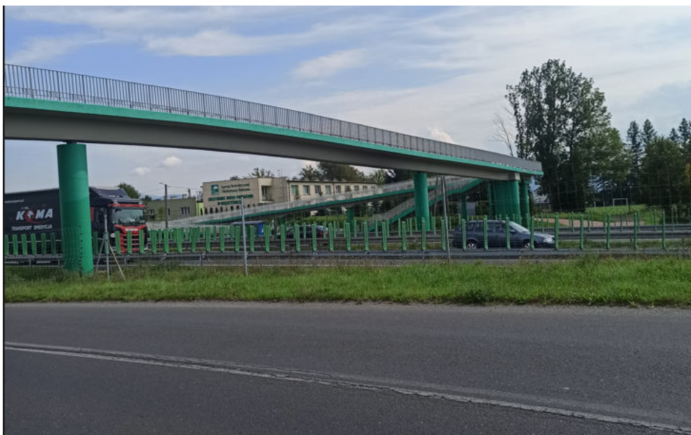
Rys. 27 Istniejący obiekt inżynierski: Kładka pieszo-rowerowa nad drogą ekspresową S52 w rejonie ul. Iskrzyczyńskiej.
