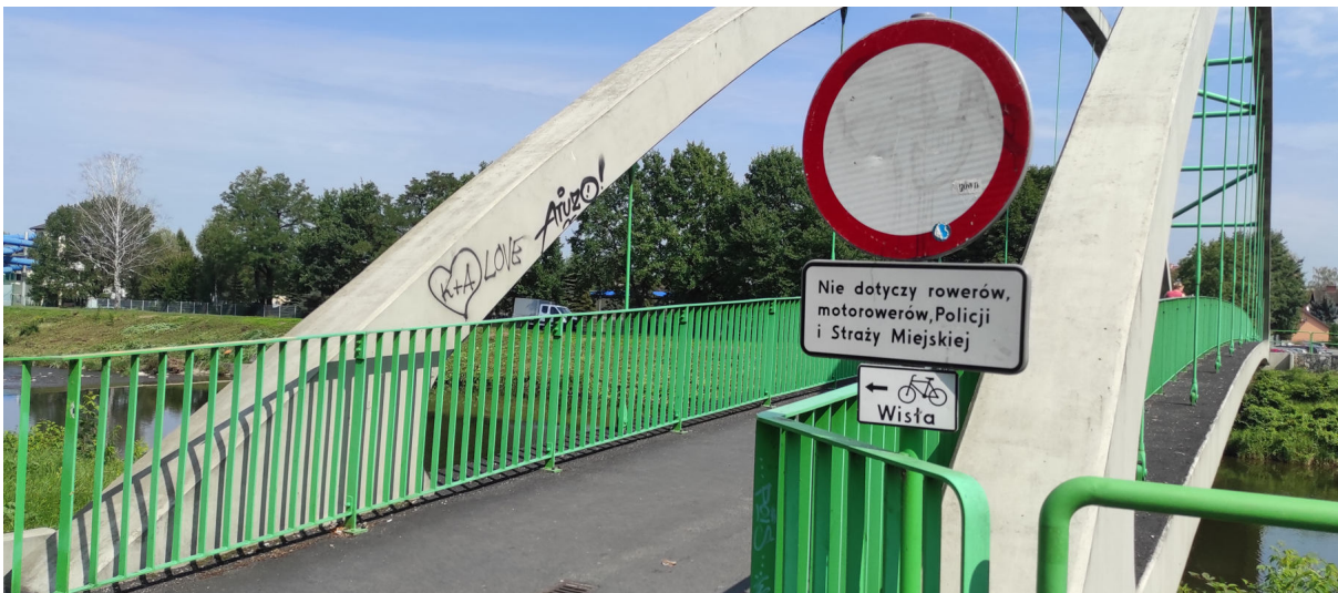
Rys. 14 Istniejąca kładka pieszo-rowerowa w rejonie ul. Sportowej.
