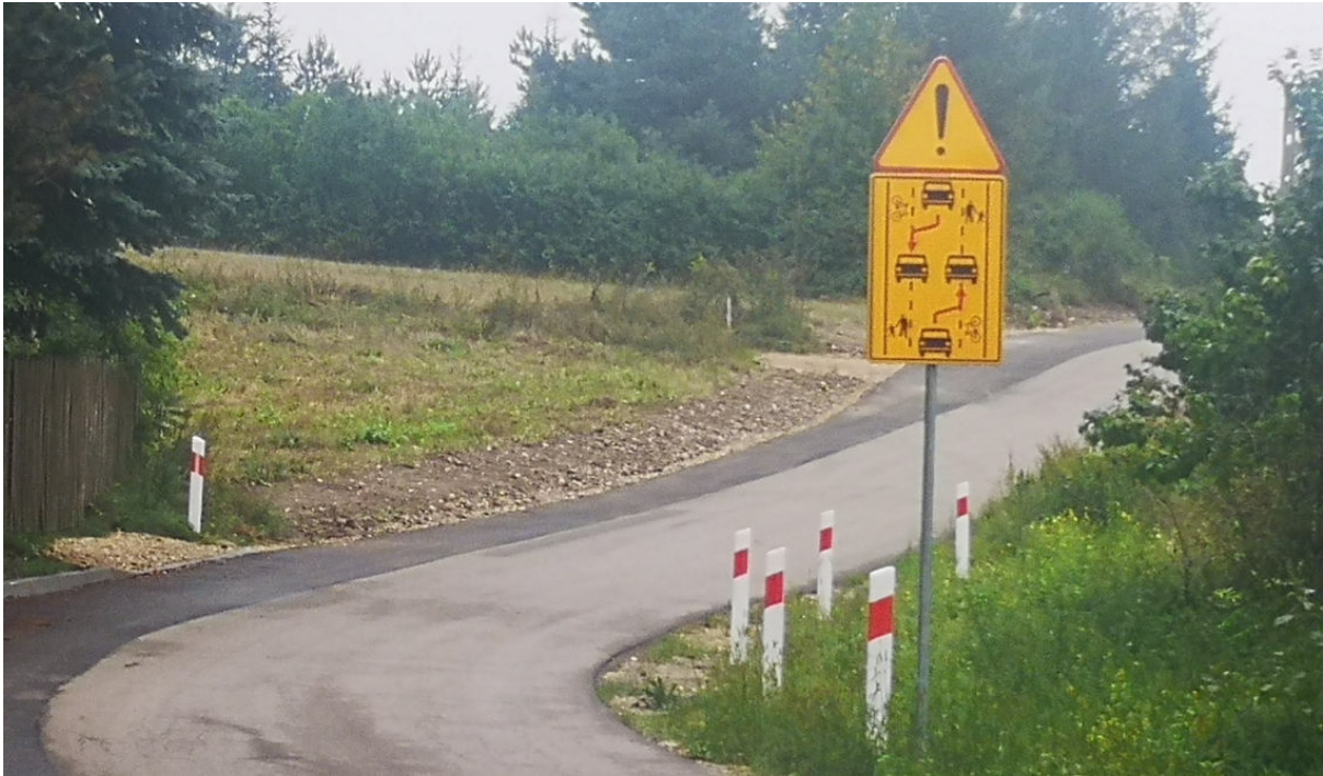
Rys 21 23 Przykład zastosowania pilotażowego w gminie Żarki. Inwestycja w trakcie realizacji.
