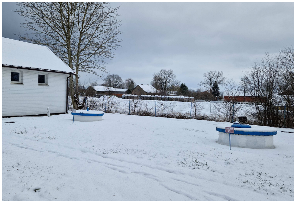
Fot. 3. Obudowa studni głębinowej nr 1 i nr 2
