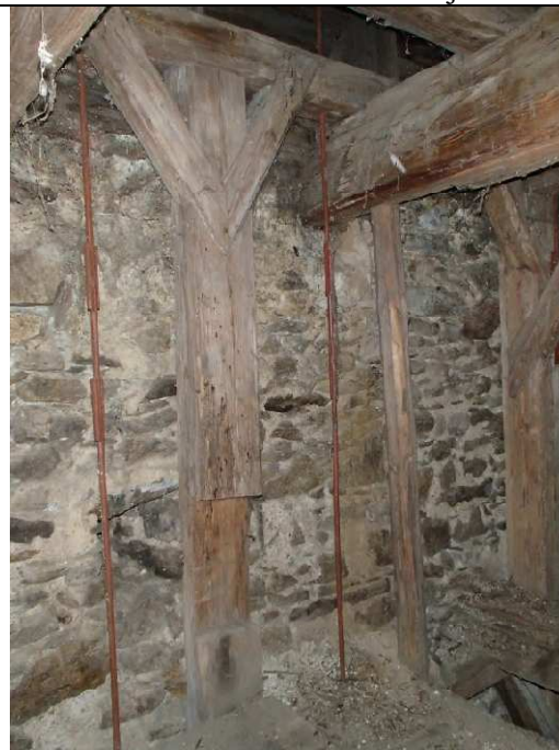
Foto 2.50. Konstrukcja wsporcza. widoczne: zaawansowana korozja biologiczna, wzmocnienie konstrukcji
