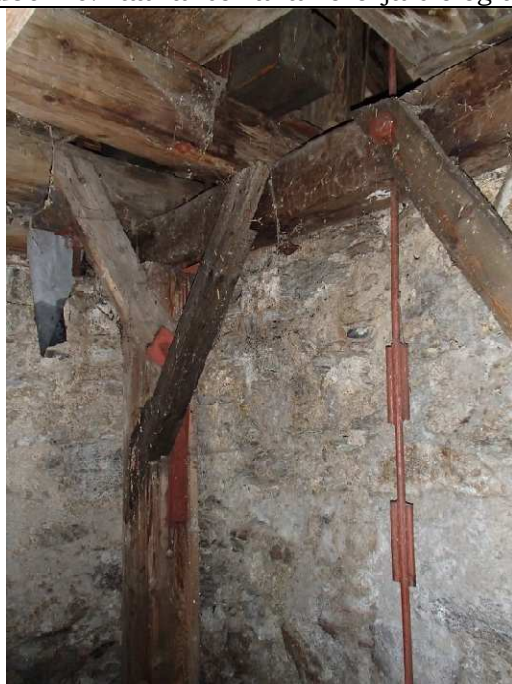
Foto 2.59. Konstrukcja wsporcza. widoczne: zaawansowana korozja biologiczna, wzmocnienie konstrukcji
