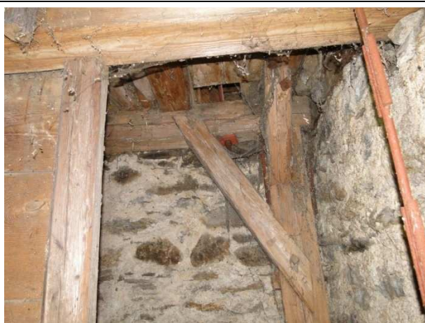
Foto 2.5. Konstrukcja wsporcza w dolnej części wieży. widoczne: zaawansowana korozja biologiczna
