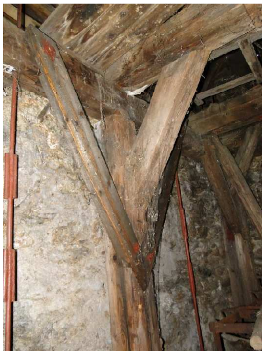
Foto 2.7. Konstrukcja wsporcza w dolnej części wieży. widoczne: zaawansowana korozja biologiczna, zawilgocenia, wzmocnienie konstrukcji
