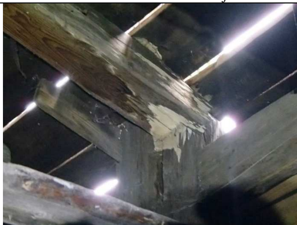
Foto 2.61. Konstrukcja wsporcza. widoczne: zaawansowana korozja biologiczna
