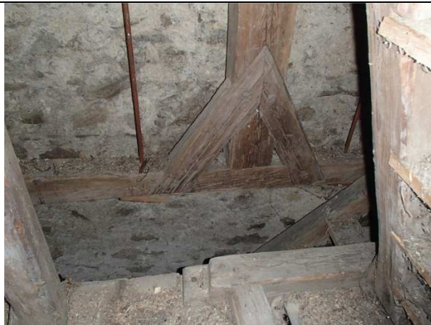
Foto 2.45. Konstrukcja wsporcza. widoczne: zaawansowana korozja biologiczna
