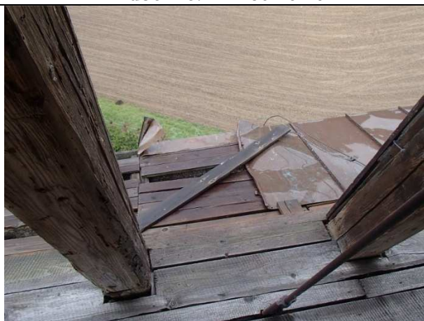
Foto 2.89. Konstrukcja dolnej latarni. widoczne: uszkodzenia poszycia
