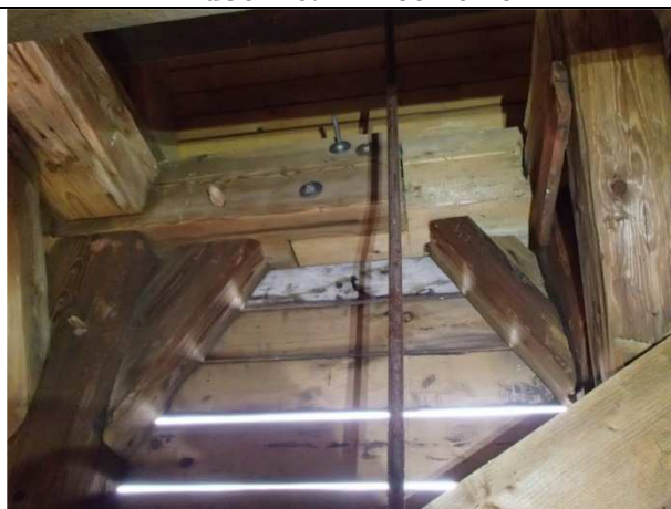
Foto 2.90. Konstrukcja dolnej latarni. widoczne: wzmocnienie
