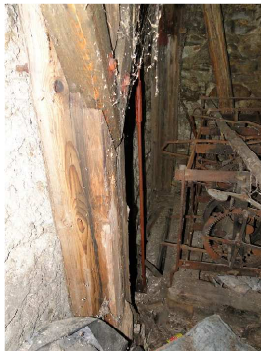
Foto 2.8. Konstrukcja wsporcza w dolnej części wieży. widoczne: zaawansowana korozja biologiczna, zawilgocenia, wzmocnienie konstrukcji
