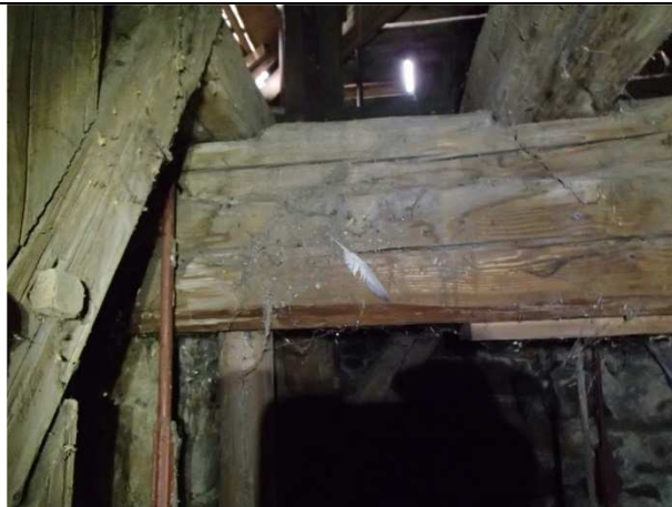
Foto 2.58. Konstrukcja wsporcza. widoczne: zaawansowana korozja biologiczna
