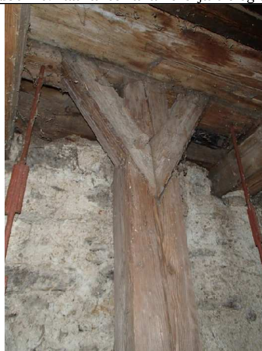
Foto 2.60. Konstrukcja wsporcza. widoczne: zaawansowana korozja biologiczna, wzmocnienie konstrukcji
