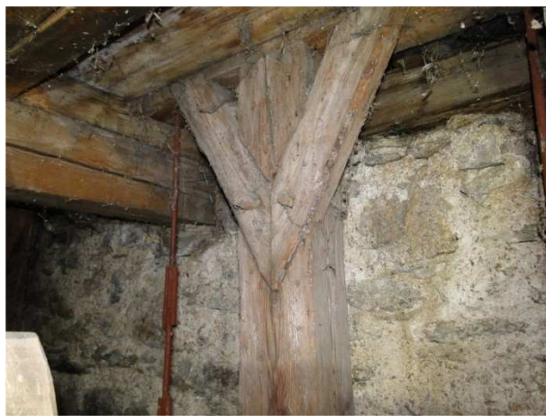
Foto 2.4. Konstrukcja wsporcza w dolnej części wieży. widoczne: zaawansowana korozja biologiczna, zawilgocenia
