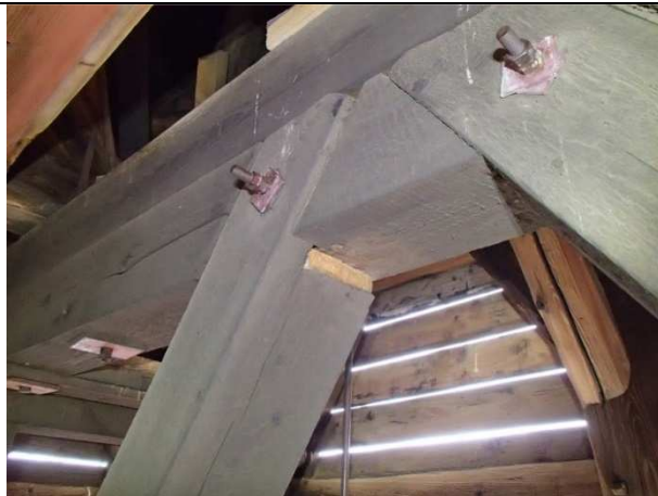
Foto 2.87. Konstrukcja dolnej latarni. widoczne: wzmocnienie
