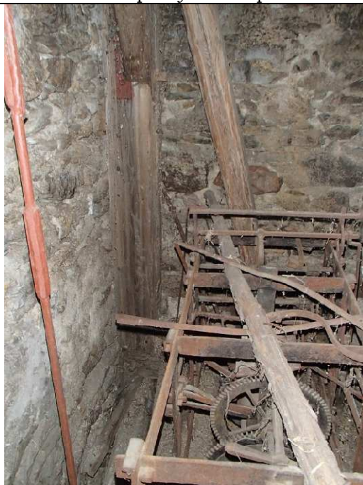
Foto 2.49. Konstrukcja wsporcza. widoczne: zaawansowana korozja biologiczna, wzmocnienie konstrukcji
