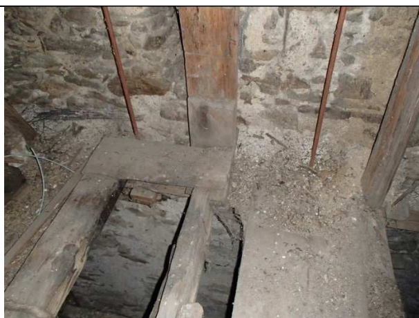
Foto 2.47. Konstrukcja wsporcza. widoczne: zaawansowana korozja biologiczna, brak poszycia stropu
