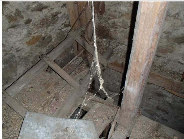
Foto 2.46. Konstrukcja wsporcza. widoczne: zaawansowana korozja biologiczna, brak poszycia stropu
