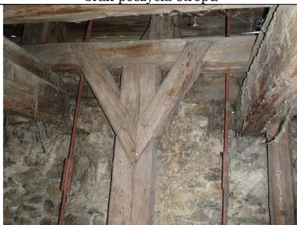
Foto 2.48. Konstrukcja wsporcza. widoczne: zaawansowana korozja biologiczna, wzmocnienie konstrukcji
