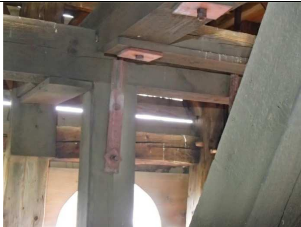
Foto 2.88. Konstrukcja dolnej latarni. widoczne: wzmocnienie
