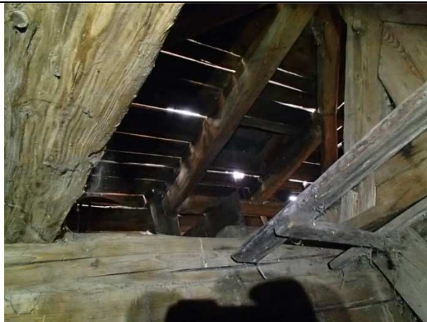
Foto 2.57. Konstrukcja wsporcza. widoczne: zaawansowana korozja biologiczna
