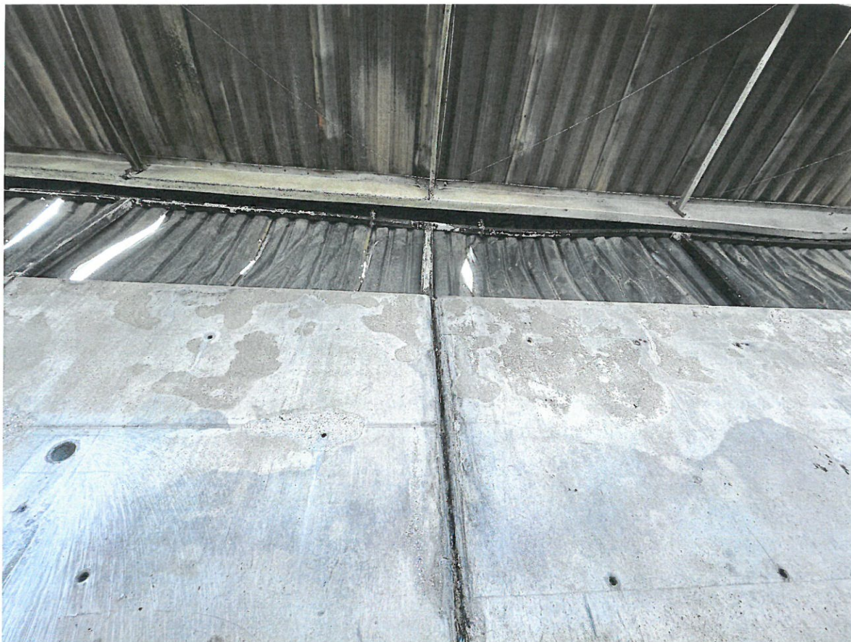
Foto nr 9. Na skutek działania wysokiej temperatury wypalona została masa dylatacyjna pomiędzy ścianami konstrukcji.
