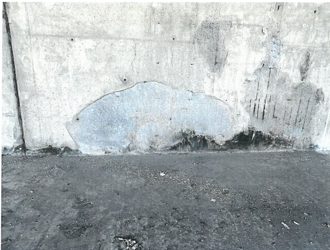
Foto nr 5. Na skutek działania bardzo wysokiej temperatury nastąpiło odspojenie części ścian żelbetowych odkrywając zbrojenie ścian.
