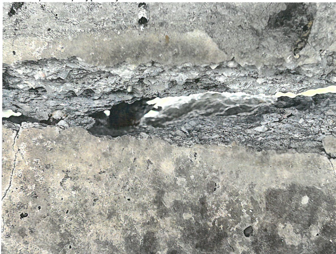
Foto nr 6. Wysoka temperatura działająca na konstrukcje stalową zadaszenia spowodowała rozerwanie ściany w miejscu kotwieni słupka.
