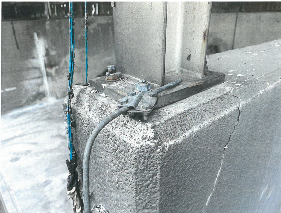
Foto nr 7. Uszkodzenie fragmentu ściany żelbetowej przez nadmierne przemieszczenie konstrukcji stalowej podczas działania wysokiej temperatury.
