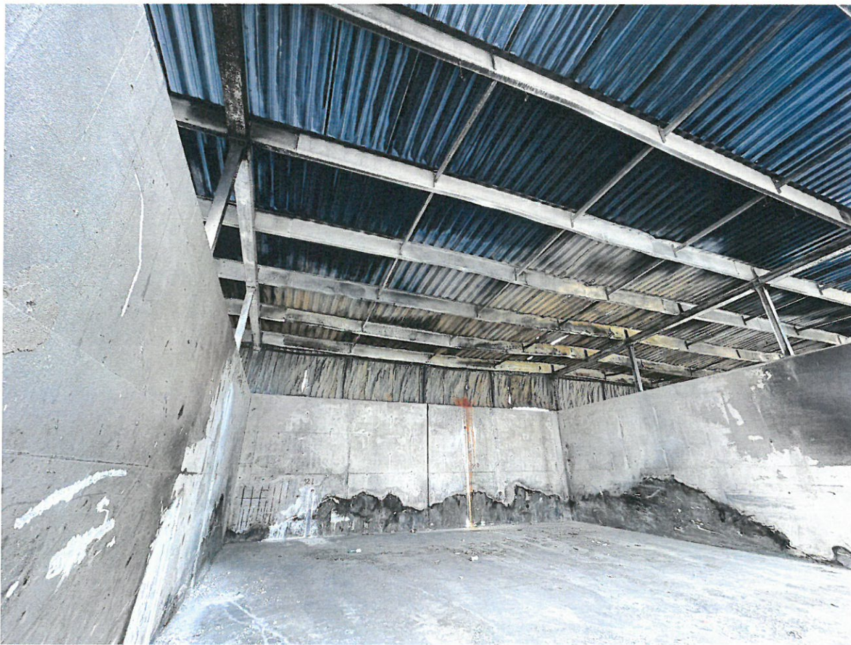
Foto nr1. Uszkodzone płatownie oraz konstrukcja wsporcza na skutek działania wysokiej temperatury.
