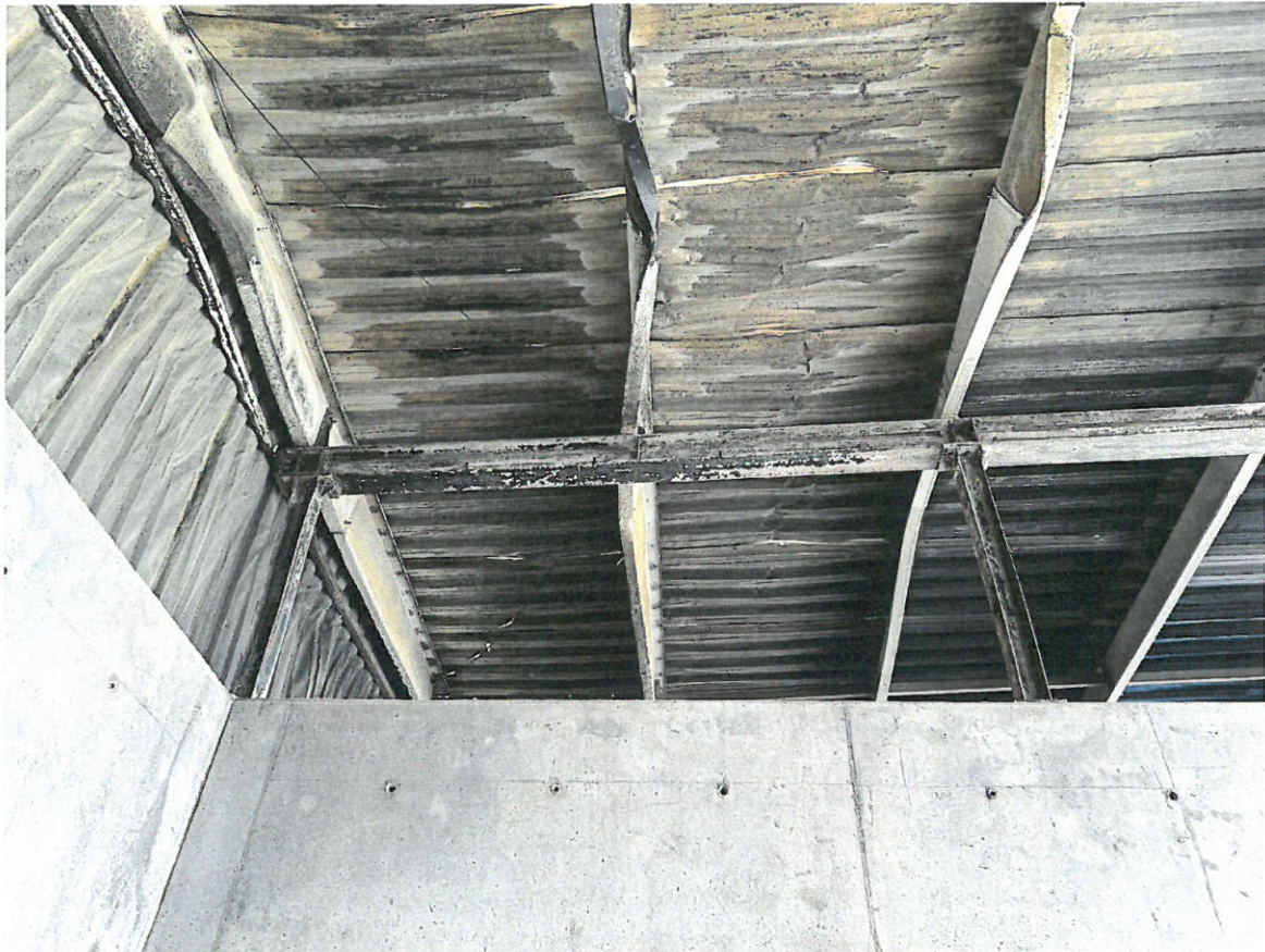
Foto nr2. Uszkodzone płatwie oraz konstrukcja wsporcza na skutek działania wysokiej temperatury.
