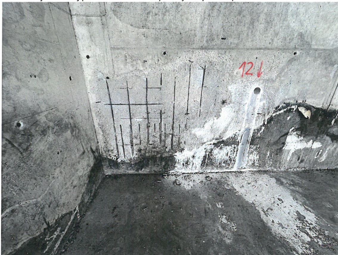
Foto nr 8. Na skutek działania bardzo wysokiej temperatury nastąpiło odspojenie części ścian żelbetowych odkrywając zbrojenie ścian.
