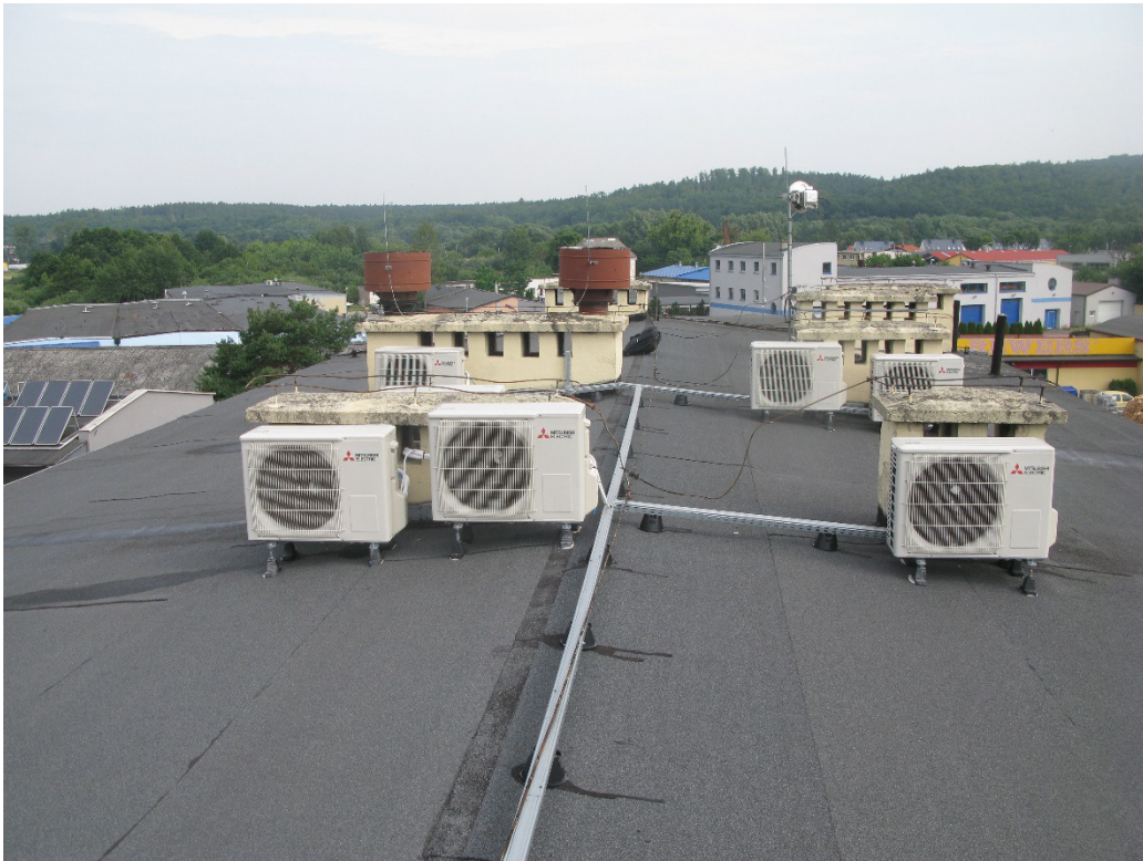
Fot. 7 Widok na połąć dachu "A" nad częścią wyższą budynku
