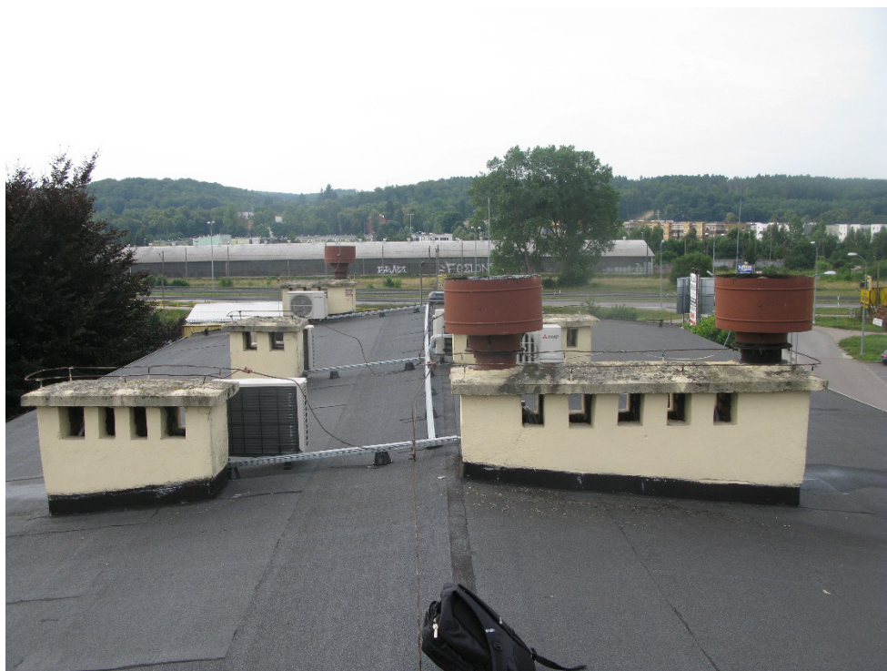
Fot. 6 Widok na połąć dachu "A" nad częścią wyższą budynku
