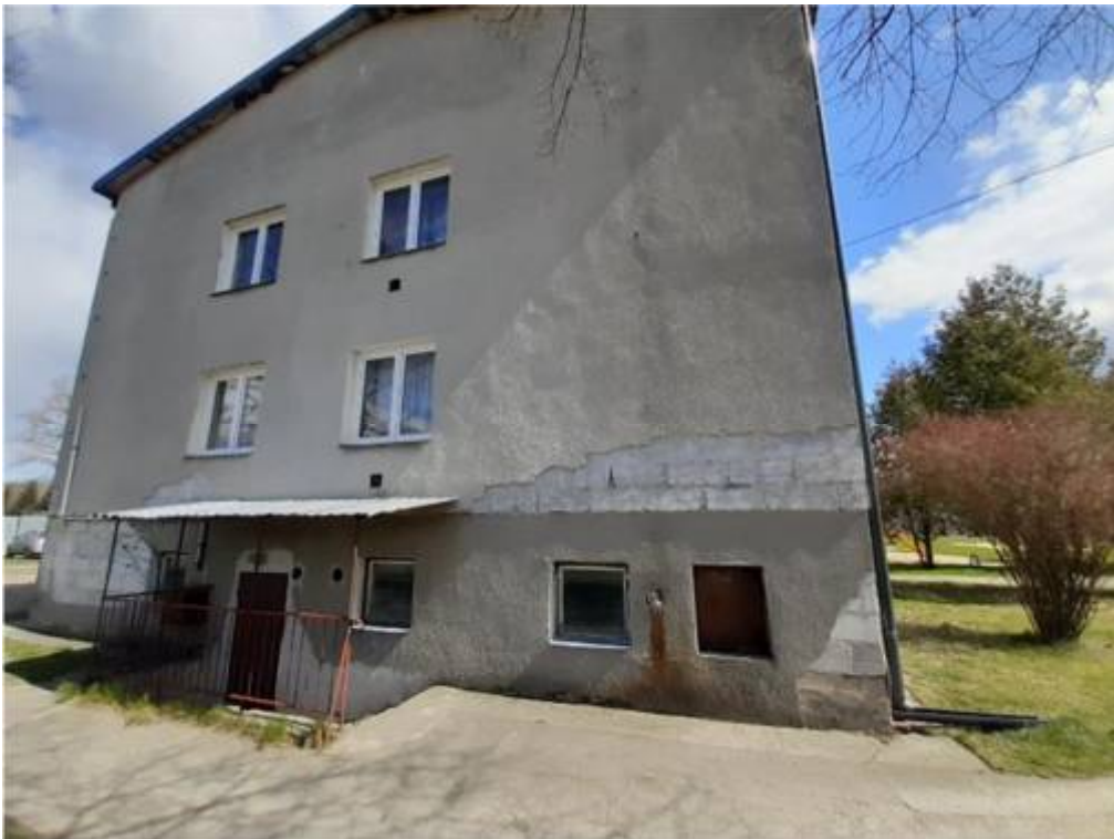
Fot. nr 9. Widok elewacji zachodniej.
