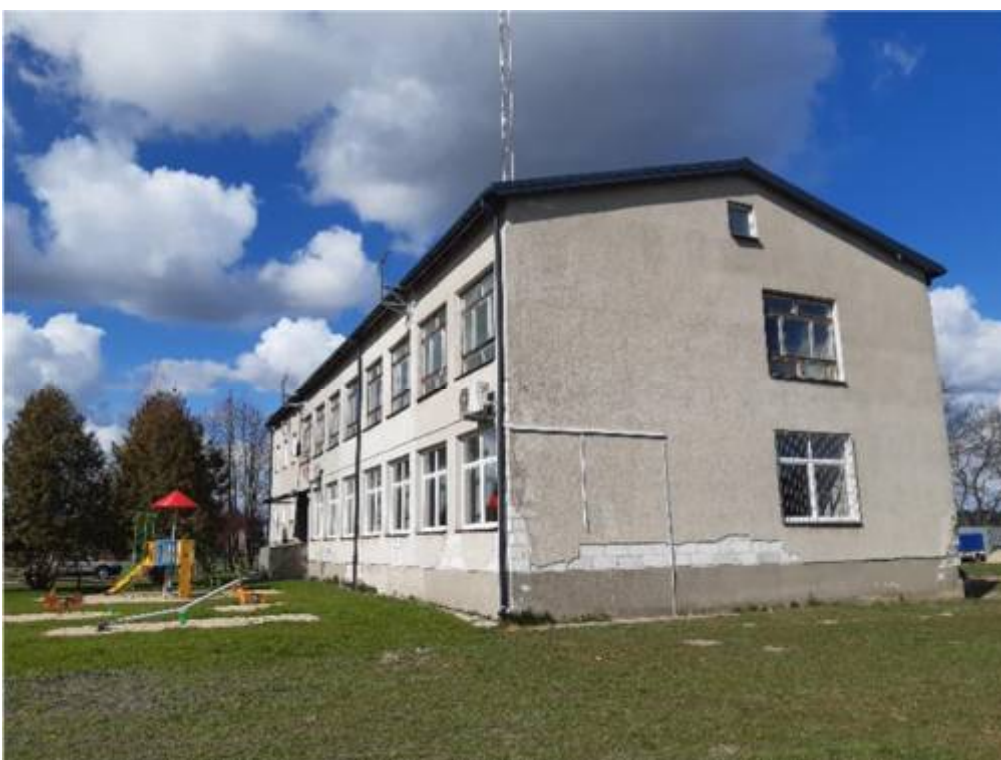
Fot. nr 5. Widok elewacji połd.- wsch.
