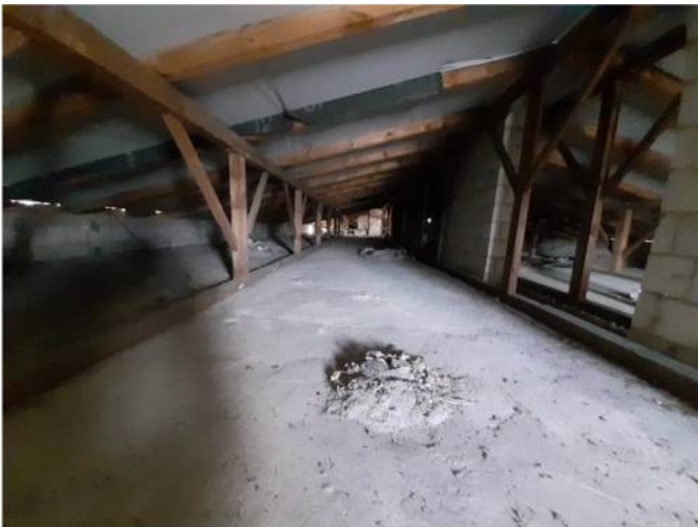
Fot. nr 11. Widok przestrzeni poddasza nieużytkowego (wieźby dachowej).
