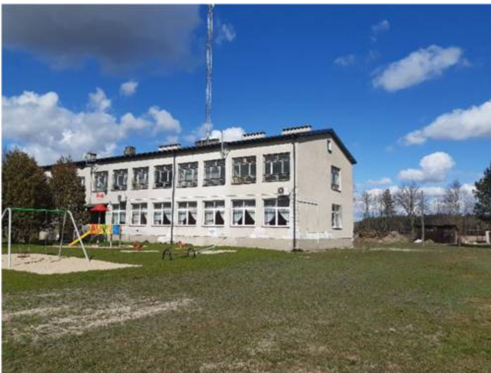
Fot. nr 4. Widok elewacji połd.- wsch.
