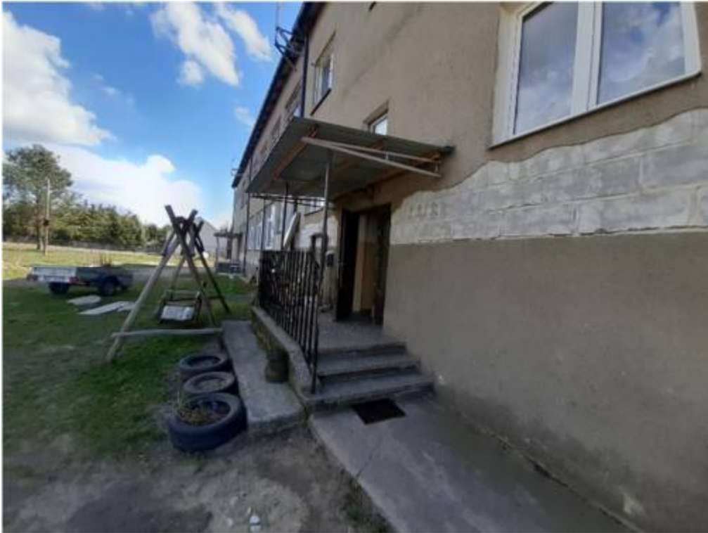
Fot. nr 8. Widok elewacji północnej- wejście do części mieszkalnej.
