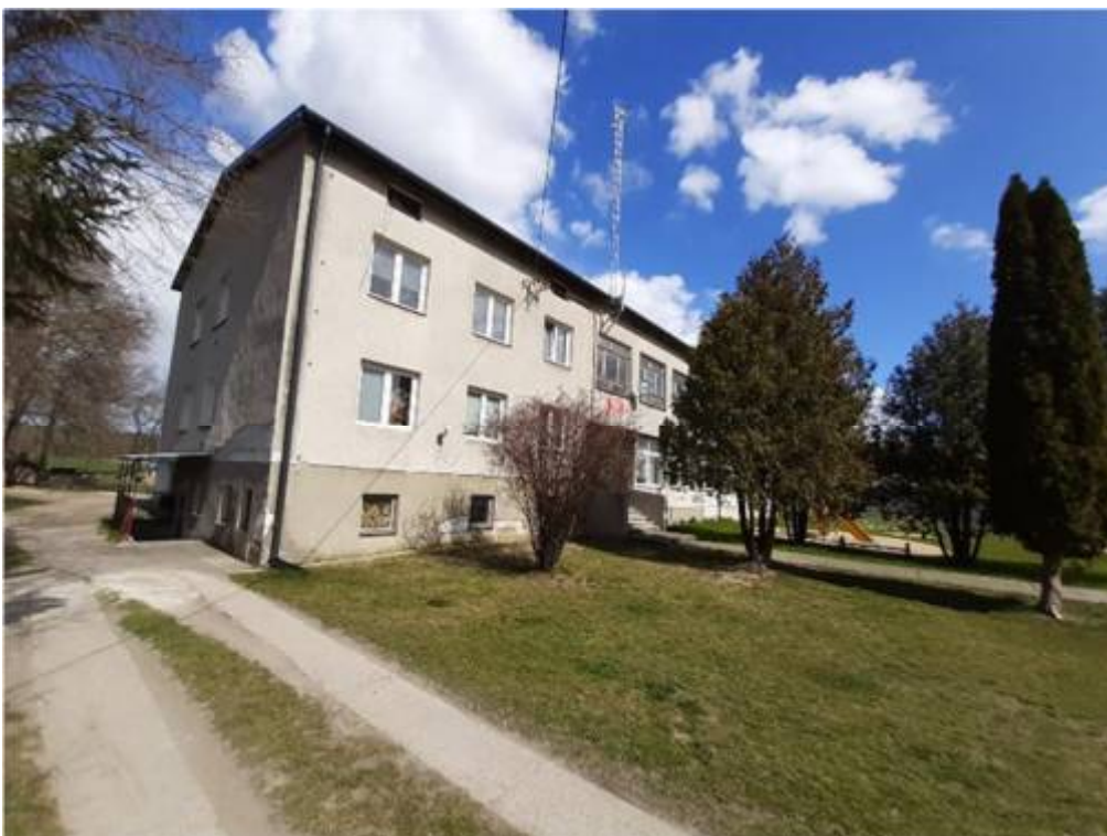
Fot. nr 2. Widok narożnika elewacji zach.-połud.
