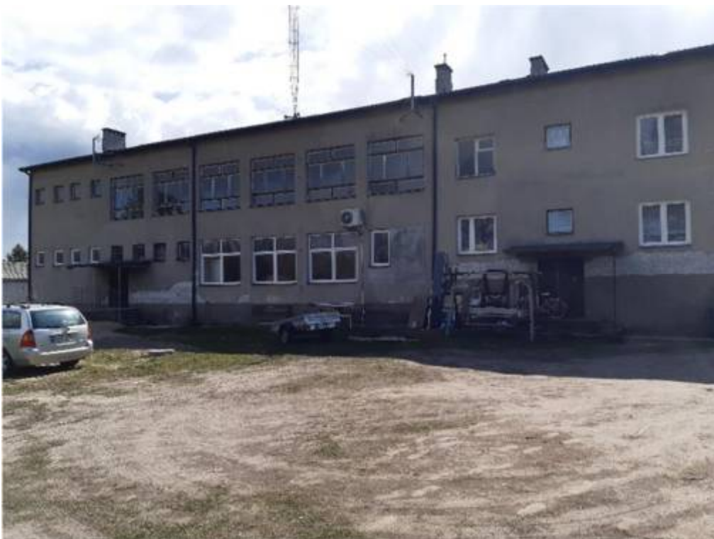
Fot. nr 7. Widok elewacji północnej.
