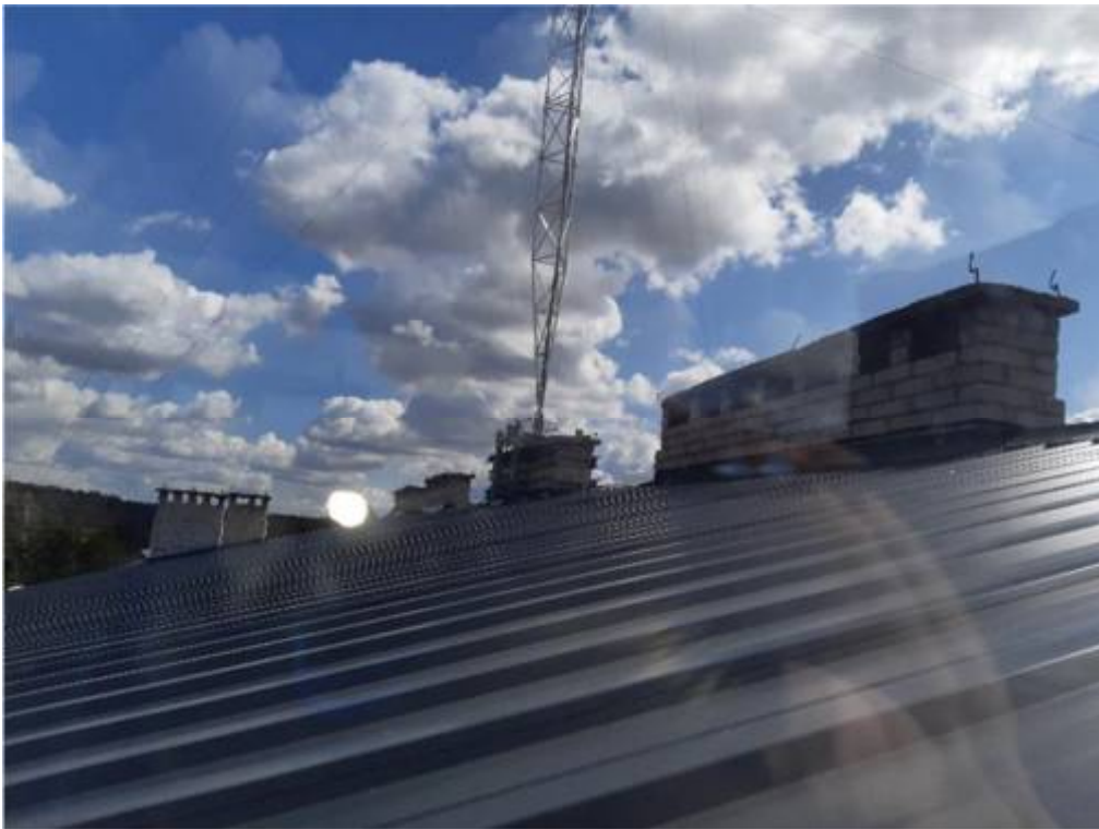
Fot. nr 13. Widok pokrycia dachu oraz kominów.
