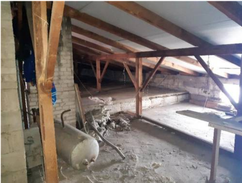
Fot. nr 10. Widok przestrzeni poddasza nieużytkowego (wieźby dachowej).
