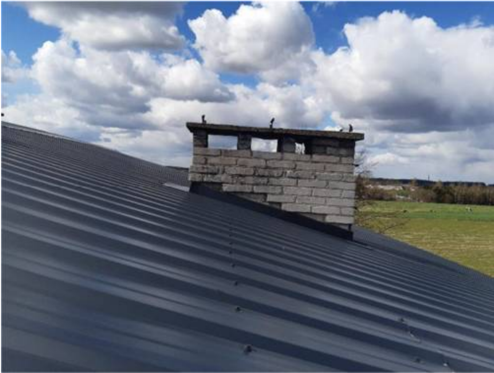
Fot. nr 12. Widok pokrycia dachu oraz komina.
