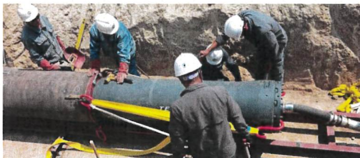
Rys. 28. Przecisk z ubijakiem umieszczonym za rurą stalową
