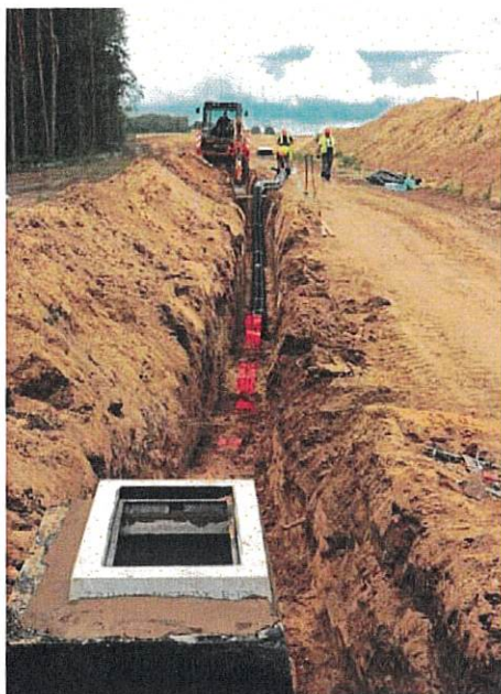
Rys. 34. Zamontowana studzienka kablowa
