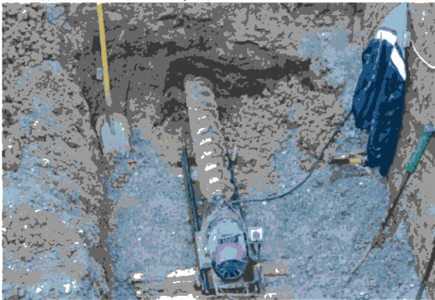
Rys. 30. Wykonywanie przewiertu
