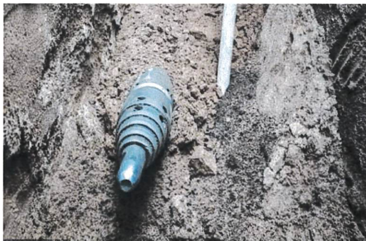
Rys. 27. Kret ciągnący rurę
