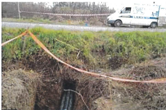
Rys. 31. Kanał kablowy umieszczony metodą przewiertu
