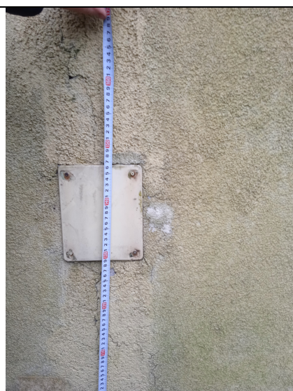
Widok na istniejące elementy instalacji odgromowej z poziomu gruntu budynku „M” :
