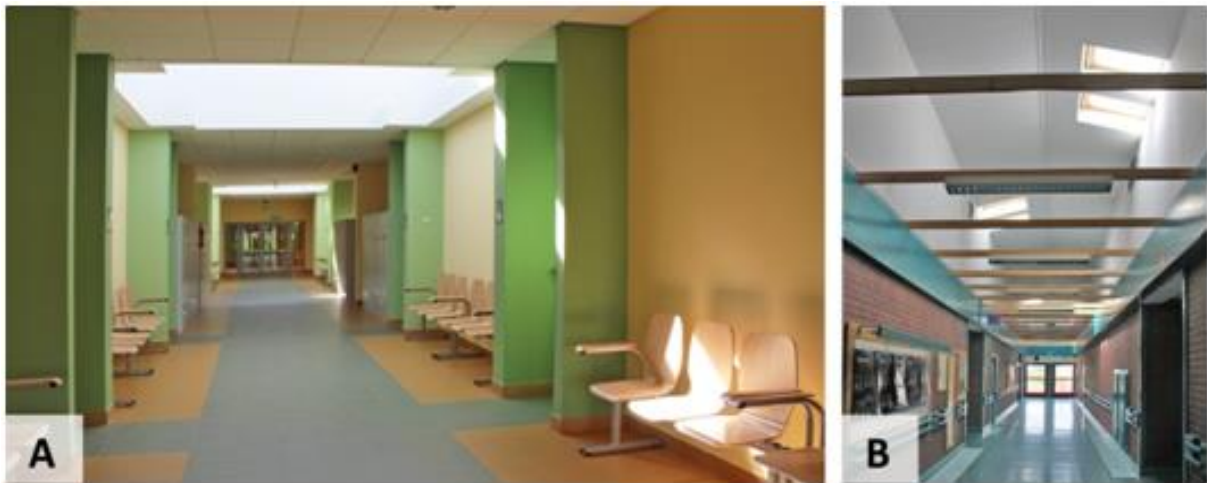
Rysunek 21. Przykład oświetlenia korytarza światłem naturalnym z okien usytuowanych w płaszczyźnie dachu, które powoduje zbyt mocne kontrasty na ścianach i posadzkach. W takich przypadkach należy stosować przysłony rozpraszające światło lub szkło antyrefleksyjne [fot. N. Ratajczak-Szponik].
