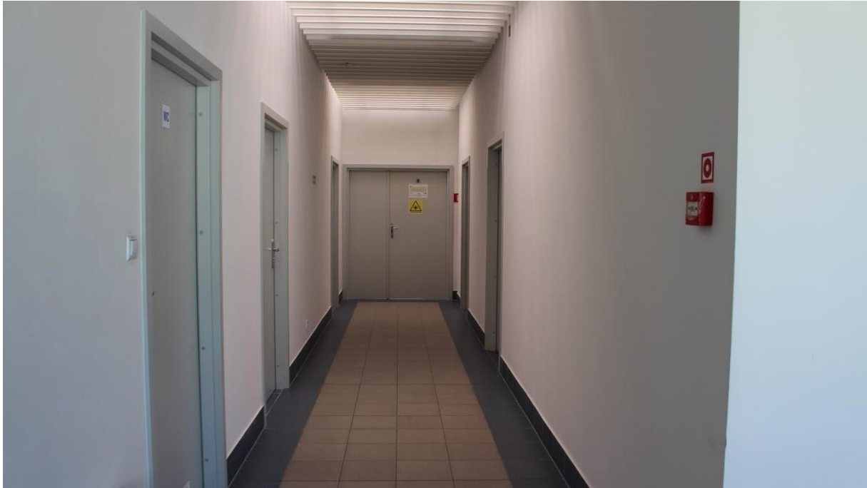
Rysunek 29. Przykład posadzki o matowym wykończeniu i liniach kontrastowych wzdłuż korytarza [fot. N. Ratajczak-Szponik].
