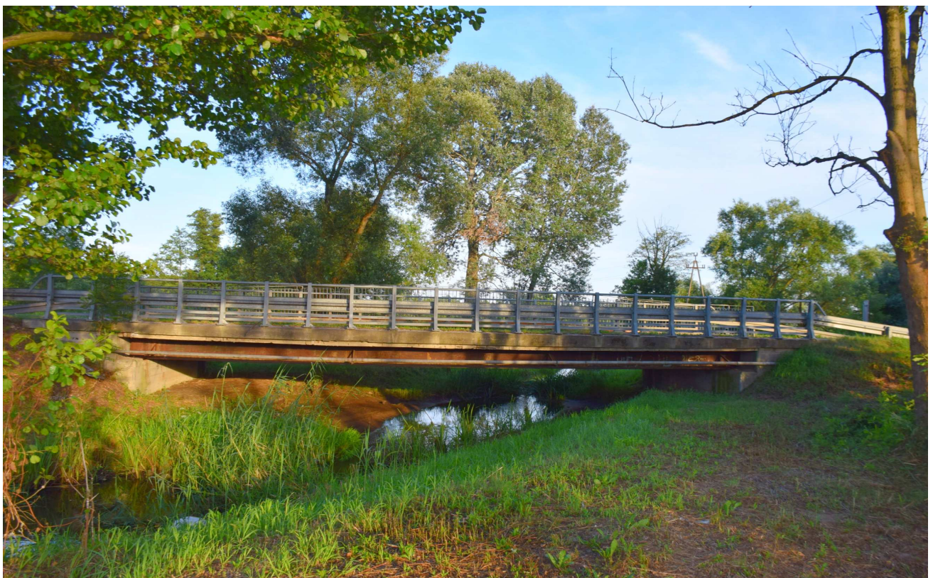
Widok ogólny obiektu mostowego
