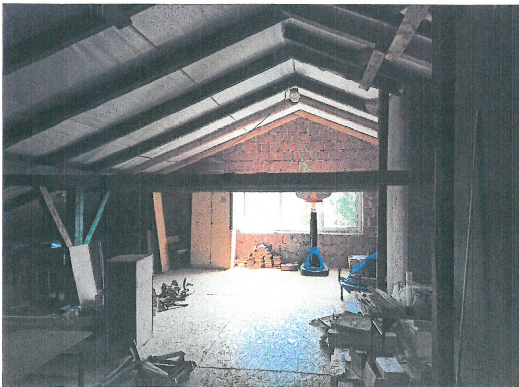
FOT. 4 WIDOK WIĘZBY DACHOWEJ
