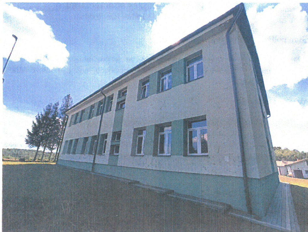
FOT. 2 WIDOK BUDYNKU
