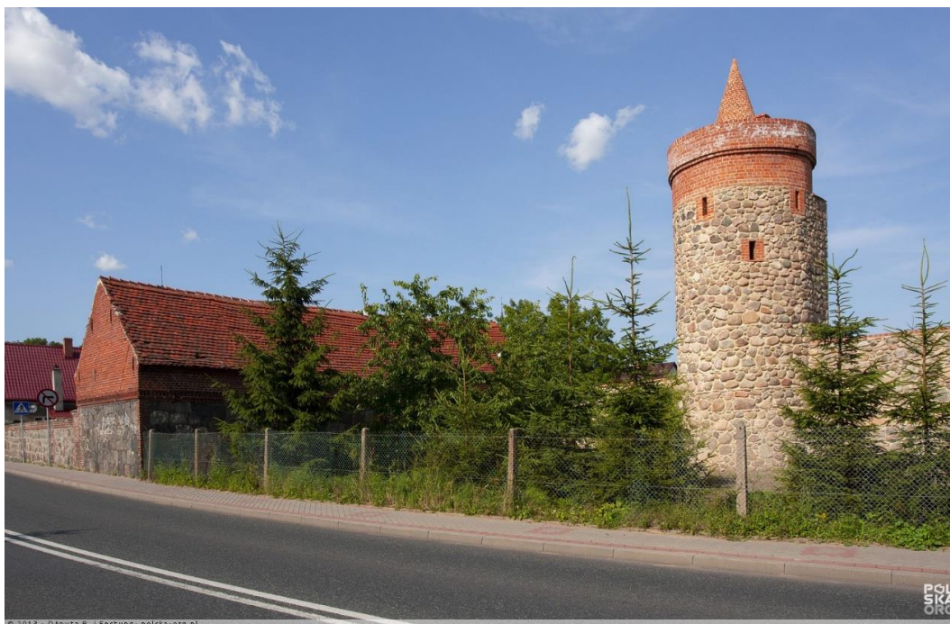
Fot. 17. Gospodarstwo składające się z domu mieszkalnego, budynku inwentarskiego i gospodarczego. Budynek gospodarczy z falującym okapem przylega do muru miejskiego, sąsiadując z basztą 44 .
