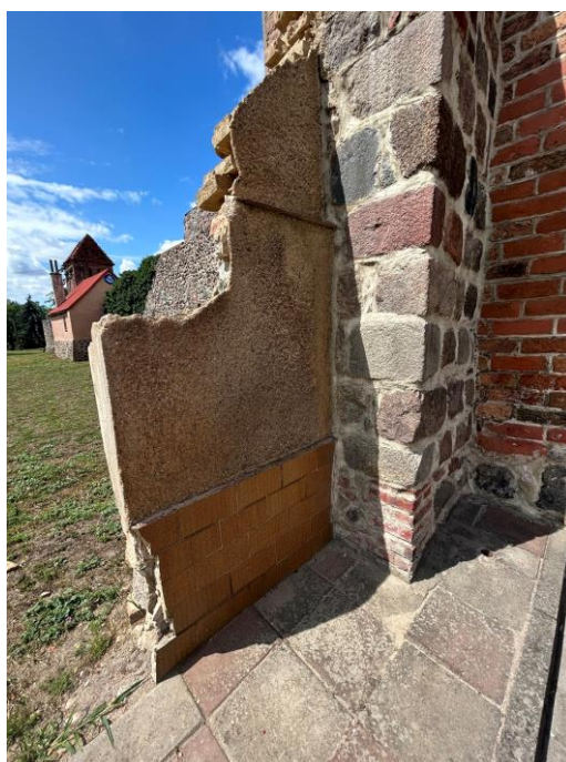
Fot. 55. Część ściany pd. Bramy Myśluborskiej wraz z reliktnami ściany nieistniejącego już budynku przy ul. Dworcowej 2
