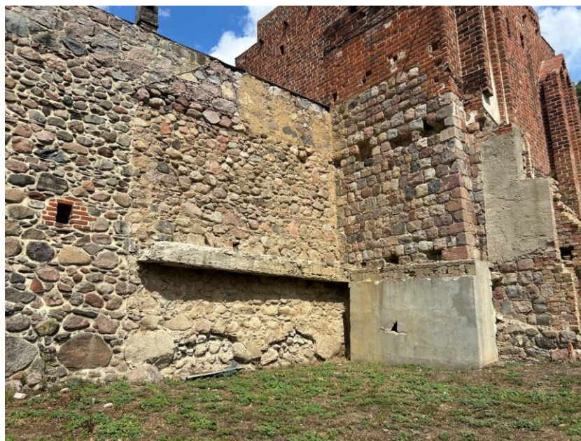
Fot. 48. Odcinek kurtyny przyległy do Bramy Myśluborskiej z widocznym obrysem nieistniejącego już budynku przy ul. Dworcowej 2
