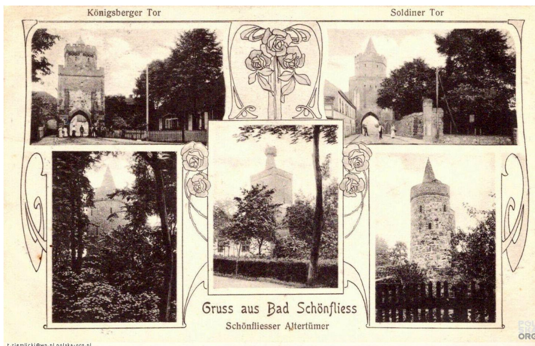
Fot. 15. Zachowane bramy i baszt dawnych murów miejskich w Trzcińsku Zdroju 39 .
