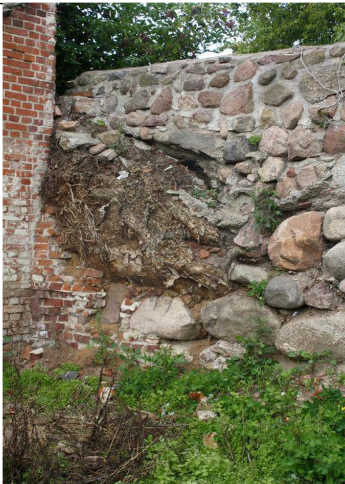
Fot. 36. Odcinek kurtyny muru z wrośniętym korzeniem – widoczne próby naprawy ubytków muru wokół korzenia
