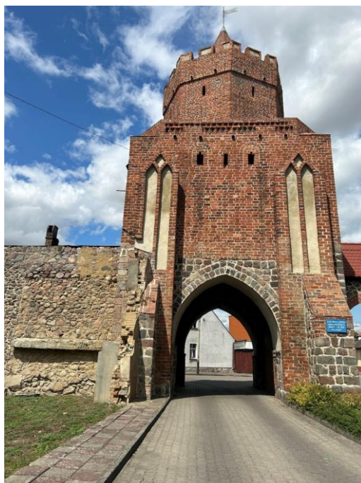
Fot. 54. Brama Myśluborska – widok ogólny (od strony południowej)
