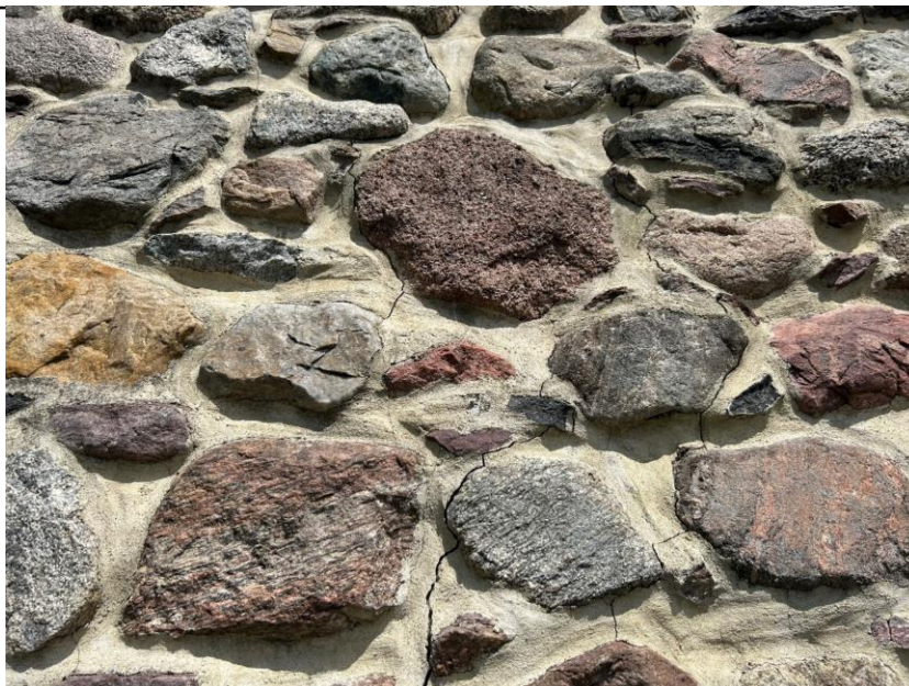
Fot. 40. Baszta łupinowa nr VIII w ciągu zabytkowych murów obronnych – pionowe przełamania mniej więcej w połowie długości muru (widok od strony południowej)
