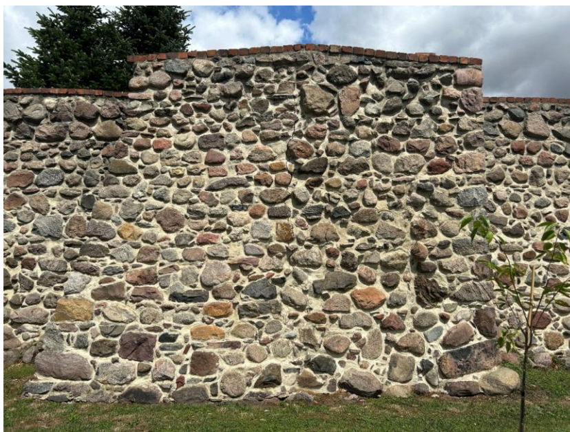
Fot. 38. Baszta łupinowa nr VIII w ciągu zabytkowych murów obronnych – widoczna wydatna deformacja powstała poprzez pionowe przełamanie mniej więcej w połowie długości ze skruceniem obu przyległych powierzchni muru
