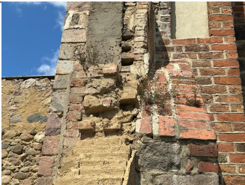
Fot. 56. Część ściany pd. Bramy Myśluborskiej – górny fragment murowanej z kwadry ściany szyi przedbramia, obecnie przekształconej w szkarpę
