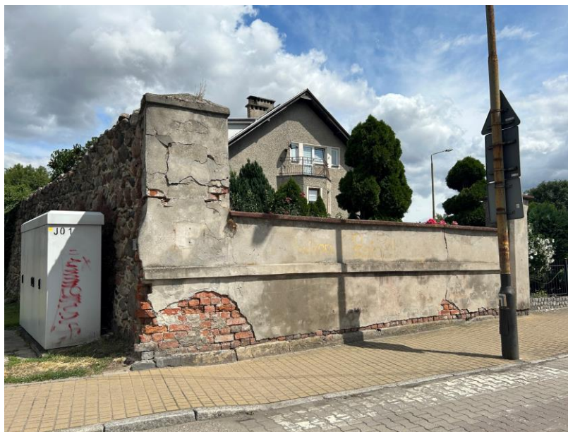
Fot. 30. Odcinek murowanego ogrodzenia przy ul. Kościuszki – widok ogólny (od strony zachodniej)
