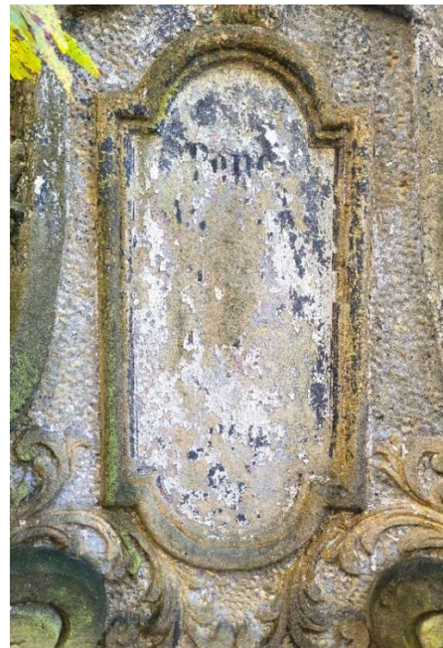
Fot. 32. Widok na prawą stronę górnej części cokółu. Zbliżenie na płaskorzeźbiony kartusz. Szczątkowo zachowały się pojedyncze litery inskrypcji wykonanej czarną farbą.
