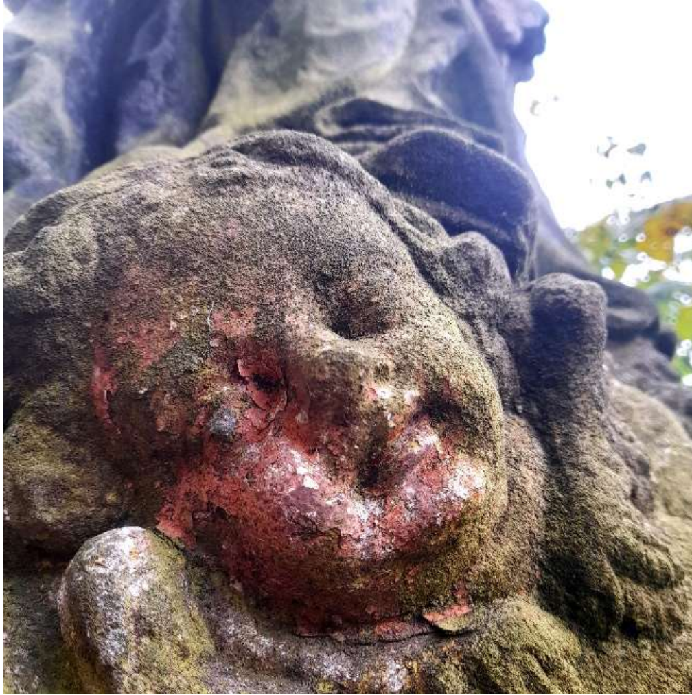
Fot. 19. Widok detalu na postumencie z prawej strony. Widać liczne spękania i złuszczenia pozostałości polichromii zachowanej na twarzy putta.
