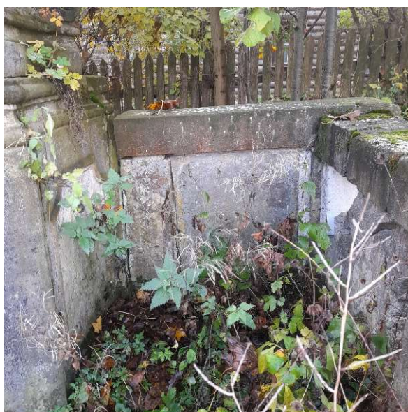
Fot. 51. Widok na wnętrze ogrodzenia, po lewej stronie rzeźby. Widoczne rośliny w partii przyziemia.
