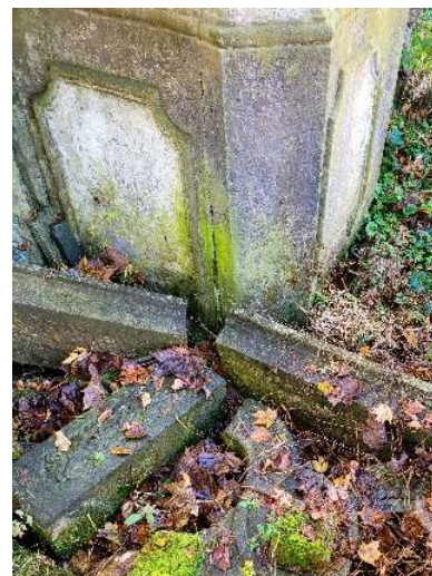
Fot. 39. Widok na dolną część prawej strony cokołu. Szczątkowo zachowana polichromia. Widoczne przebarwienia, rozwój mikroflory, a w przyziemiu roślinności oraz leżące fragmenty balustrady.
