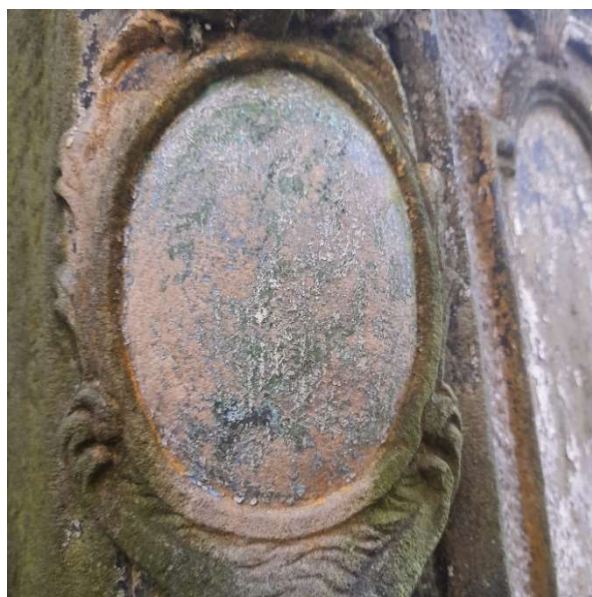
Fot. 33. Widok na prawą stronę górnej części cokołu, bliżej odwrocia. Zbliżenie na płaskorzeźbiony eliptyczny kaboszon i szczątkowo zachowaną polichromię
