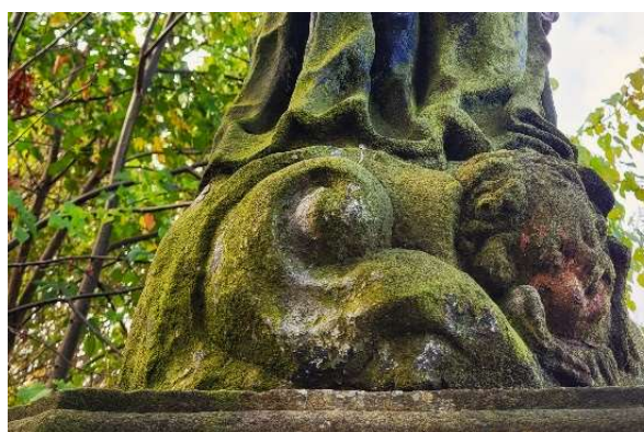
Fot. 18. Widok na postument z prawej strony. Widoczny znaczny rozwój mchów i porostów oraz pozostałości polichromii na twarzach putt.
