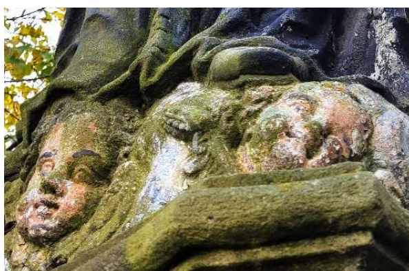
Fot. 17. Widok na postument z lewej strony. Widoczny znaczny rozwój mchów i porostów oraz pozostałości polichromii na twarzach putt.
