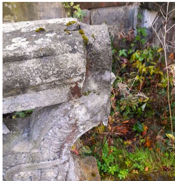
Fot. 45. Widok na frontową część kamiennego ogrodzenia, zbliżenie na zachowany detal balustrady z wtórną zaprawą cementową.
