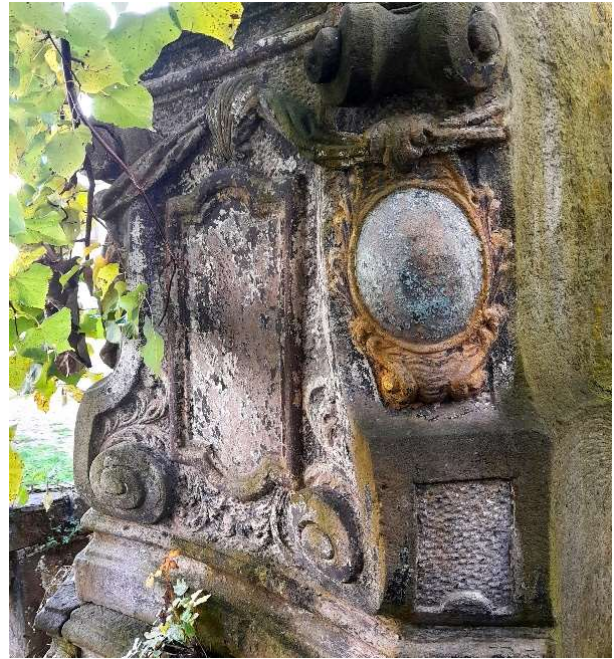
Fot. 30. Widok na lewą stronę górnej części cokółu, bliżej odwrocia. Widoczna dobrze zachowana polichromia na większości elementów dekoracyjnych oraz roślinność porastająca cokół.
