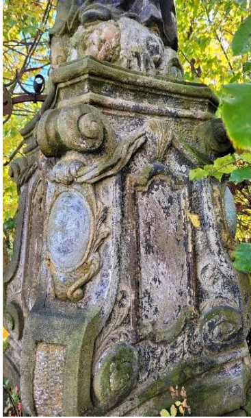
Fot. 20. Widok na górną część cokołu z lewej strony. Widoczna zachowana polichromia na niektórych elementach oraz znaczny rozwój mchów i porostów.
