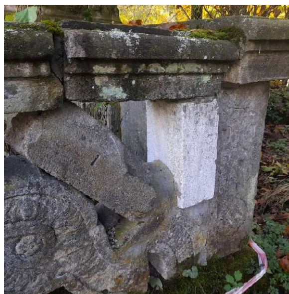
Fot. 52. Widok na tylny narożnik ogrodzenia, po lewej stronie postaci. Widoczny wstawiony pusty podtrzymujący nakrywę.
