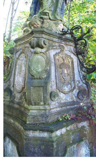
Fot. 22. Widok na górną część cokołu z prawej strony. Widoczna zachowana polichromia na niektórych elementach oraz znaczny rozwój mchów, porostów i roślinności.
