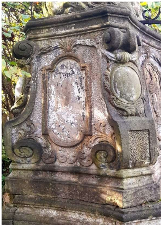
Fot. 31. Widok na prawą stronę górnej części cokółu. Z tej strony polichromia zachowana w gorszym stanie, niż po lewej. Widoczne też liczne przebarwienia na powierzchni kamienia.
