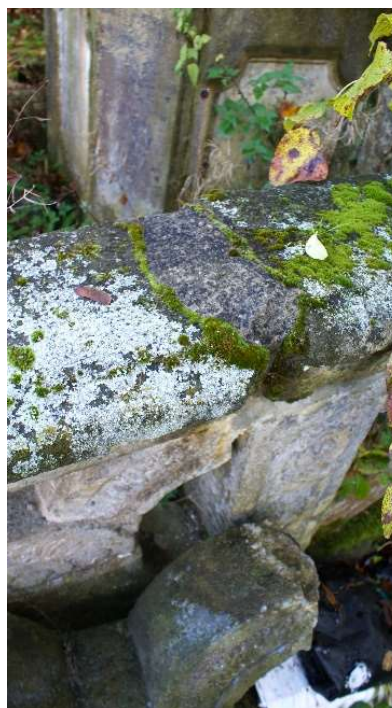
Fot. 49. Widok na lewą część ogrodzenia. Widoczne uzupełnienie formy balustrady z wykorzystaniem zaprawy cementowej.
