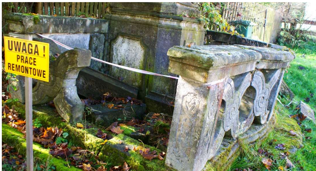
Fot. 50. Widok na prawą część ogrodzenia, w 75% jest niekompletną. Został zachowany tylko jeden element w formie zaokrąglonej litery „x”.
