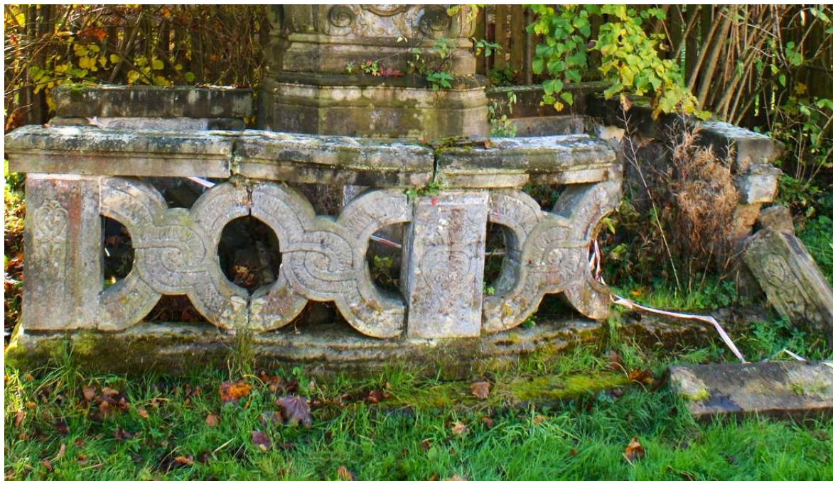
Fot. 41. Widok frontu kamiennego ogrodzenia w formie ażurowej balustrady. Widoczne liczne przebarwienia na powierzchni kamienia oraz skupiska mchów i porostów. Brak jednego segmentu balustrady, przewrócony prostopadłościenny narożnik.
