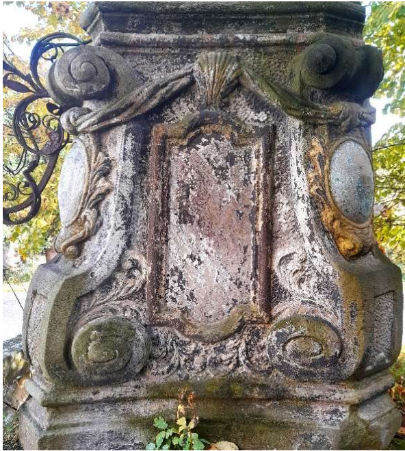
Fot. 29. Widok na lewą stronę górnej części cokółu. Widoczna dobrze zachowana polichromia na większości elementów dekoracyjnych oraz roślinność porastająca cokół.
