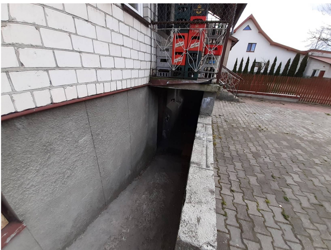
Fot. nr 7. Elewacja zachodnia- zejście do części piwnicznej.
