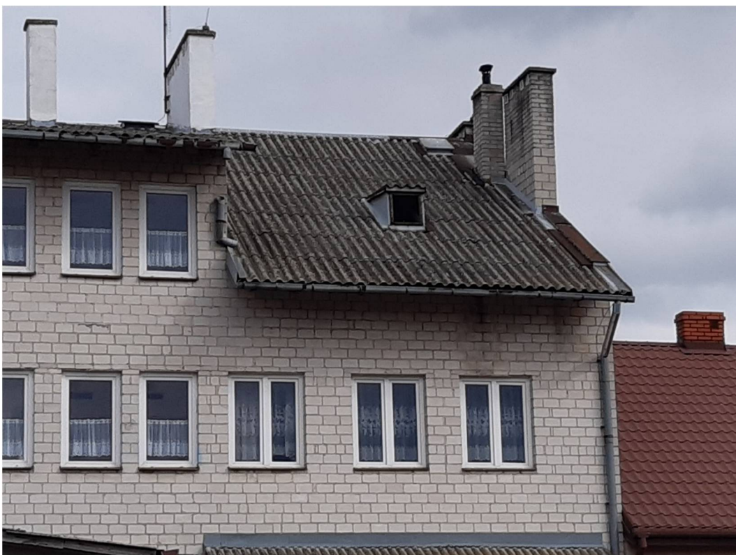
Fot. nr 10. Elewacja zachodnia.
