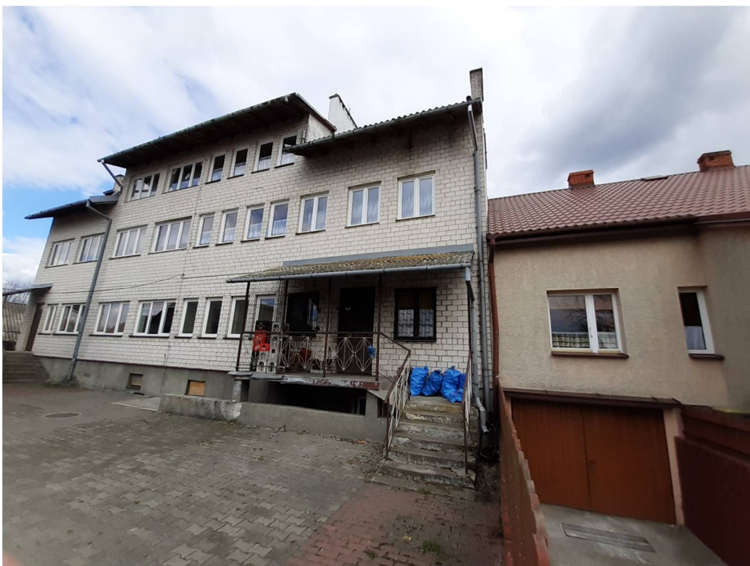
Fot. nr 12. Elewacja zachodnio- południowa.
