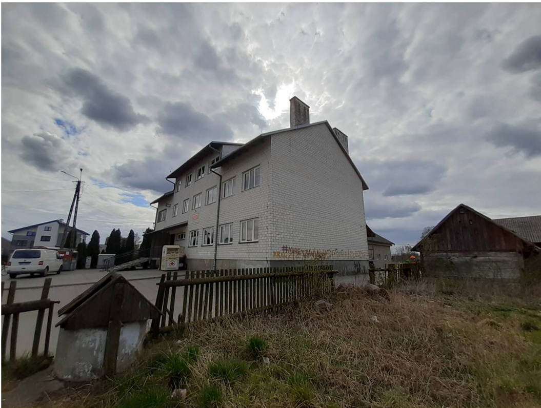
Fot. nr 4. Elewacja wschodnio- północna.
