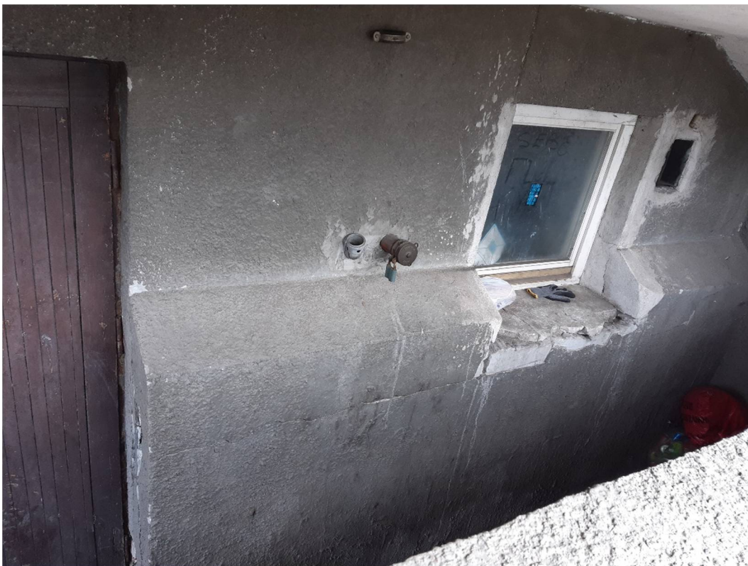
Fot. nr 8. Elewacja zachodnia- zejście do części piwnicznej.
