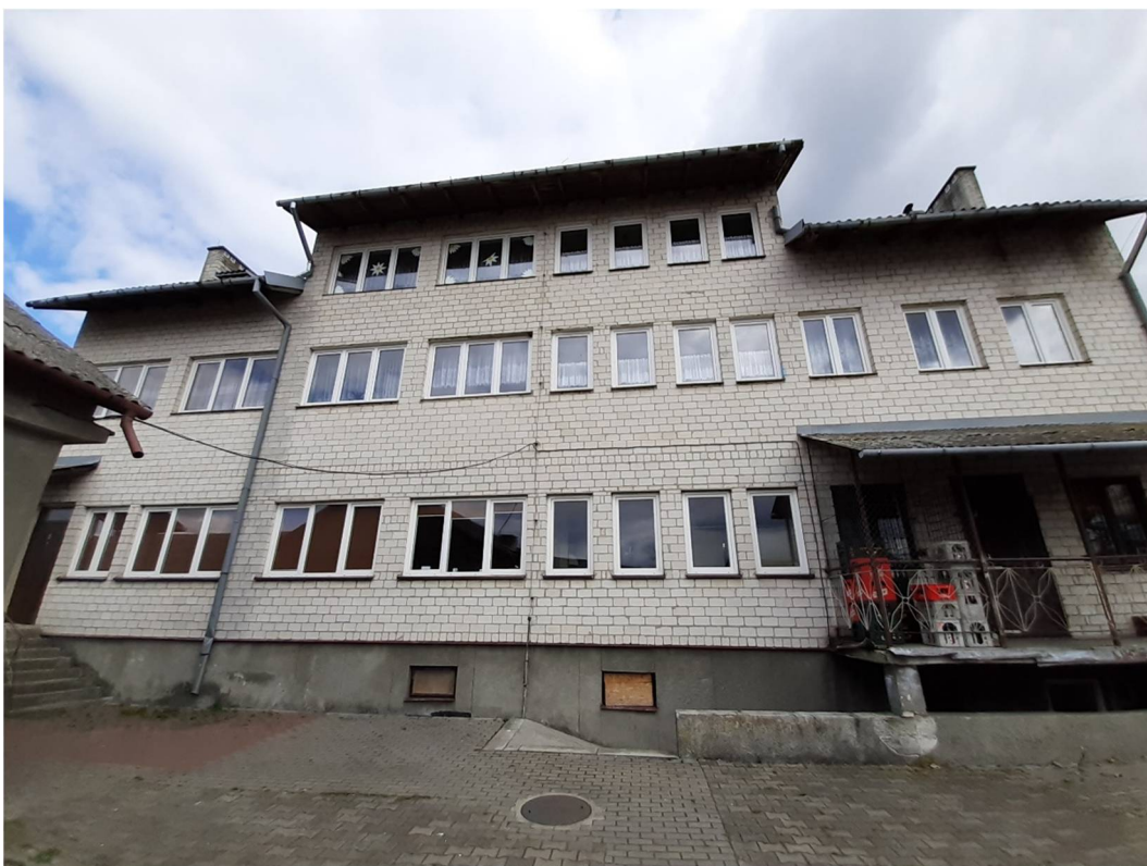
Fot. nr 6. Elewacja zachodnia.
