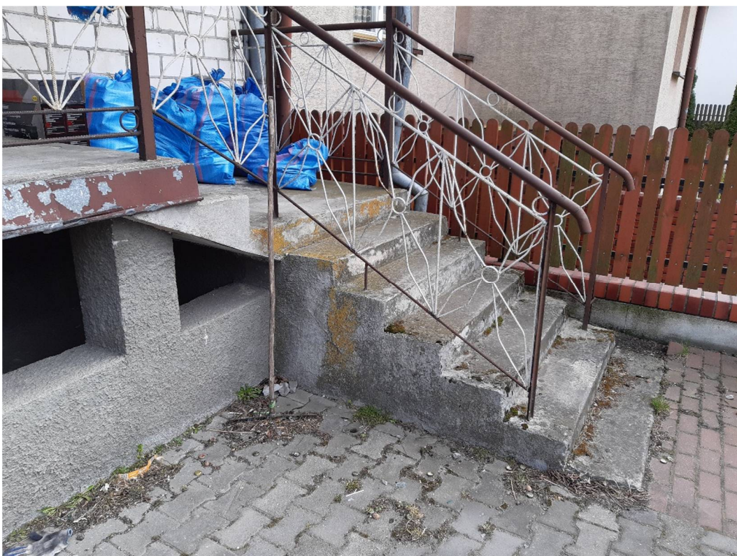
Fot. nr 9. Elewacja zachodnia.
