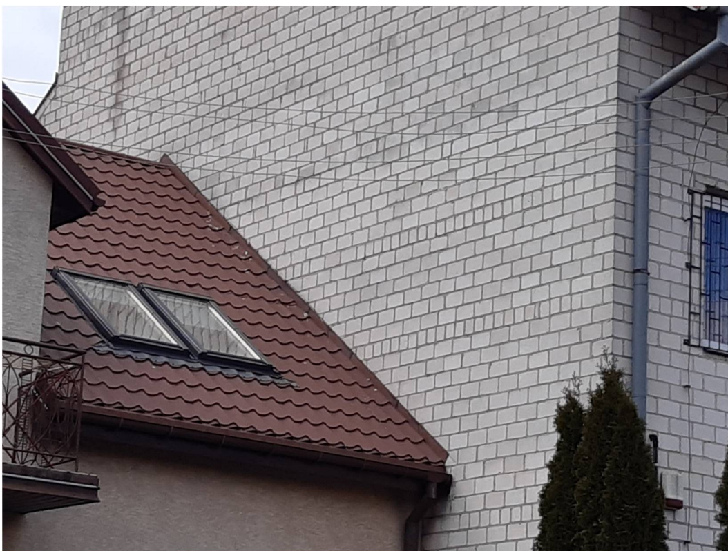
Fot. nr 14. Elewacja południowa
