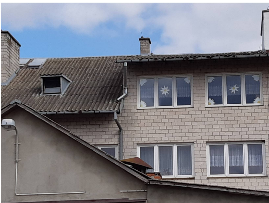
Fot. nr 11. Elewacja zachodnia.
