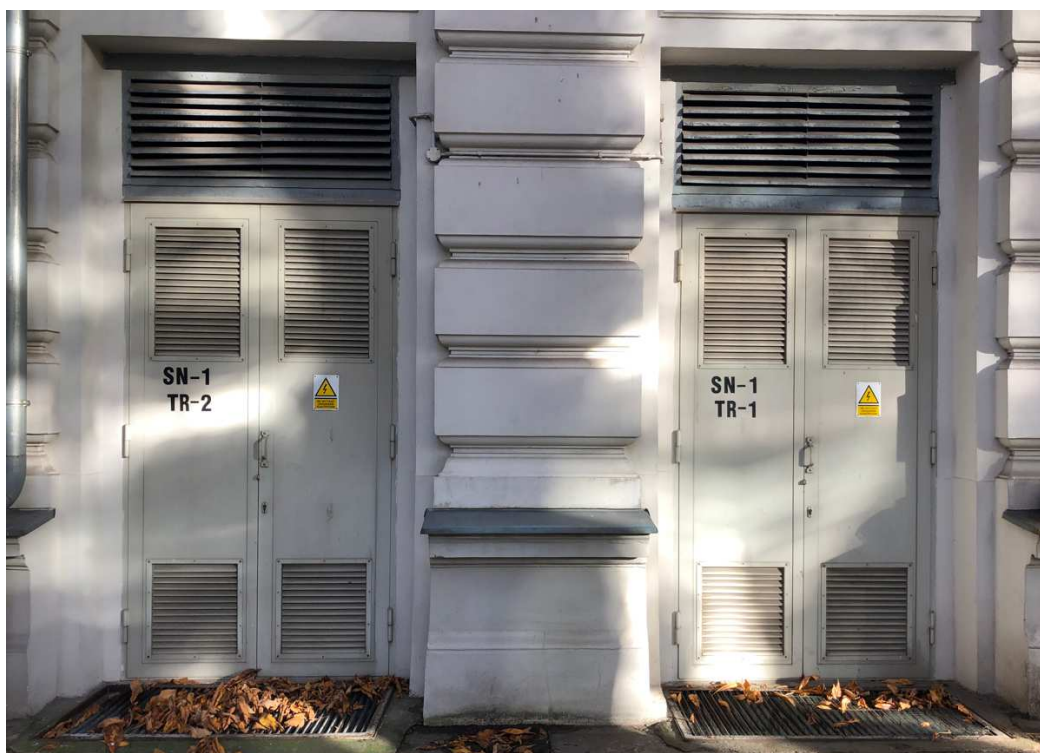
Widok komór transformatorowych przy R1-0.
