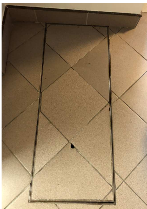
Rewizja kanału kablowego w budynku Wydziału Elektrotechnicznego
