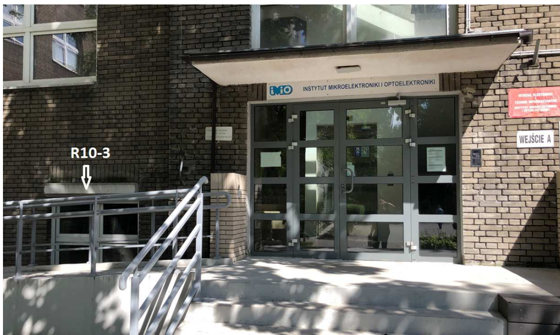
Rys. 4. Prezentacja lokalizacji rozdzielnic R10-3 od frontu budynku Wydziału Elektroniki i Techniki Informatycznych, Instytut Mikroelektroniki i Optoelektroniki
