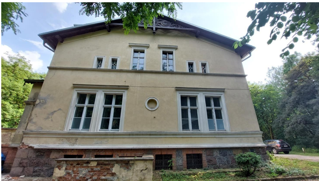
Elewacja północna, stan istniejący: maj 2023 r.
