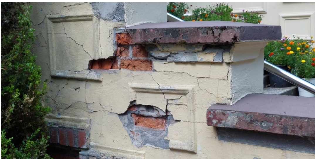
Elewacja frontowa wschodnia, murek oporowy schodów. Stan istniejący maj' 2023 r.
