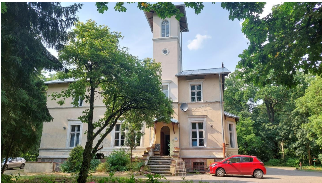
Elewacja południowa z wieżą widokową, stan istniejący: maj 2023 r.
