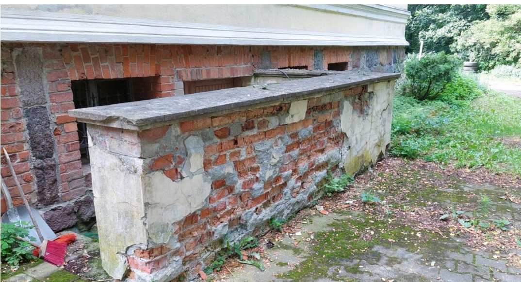
Elewacja północna, murek oporowy schodów do piwnicy. Stan istniejący maj' 2023 r.
