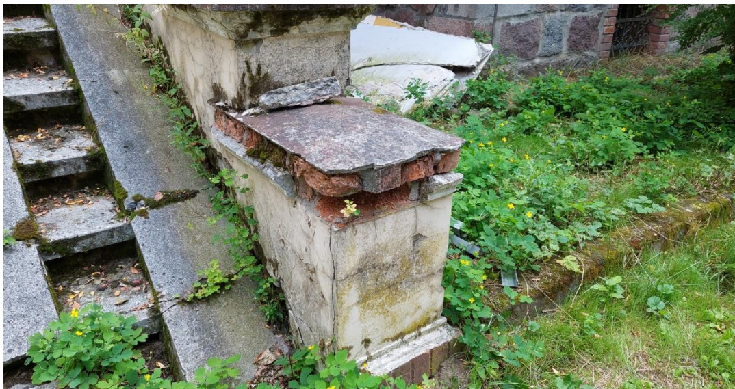
Elewacja zachodnia, murek oporowy schodów. Stan istniejący maj' 2023 r.
