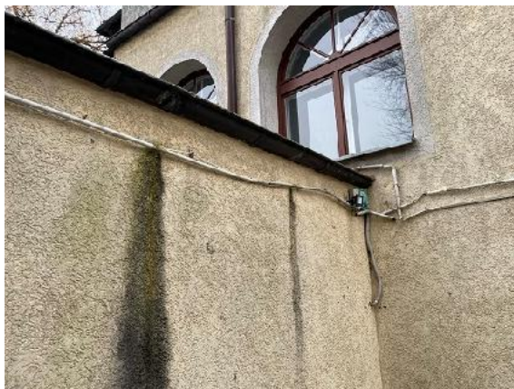
Zdj. nr 7 i 8. Elewacja przybudówki budynku przy ul. Księdza Piotra Skargi 15 w Szczecinie. Widoczne ślady zalewania elewacji spowodowane nieuszczelną rynną.
