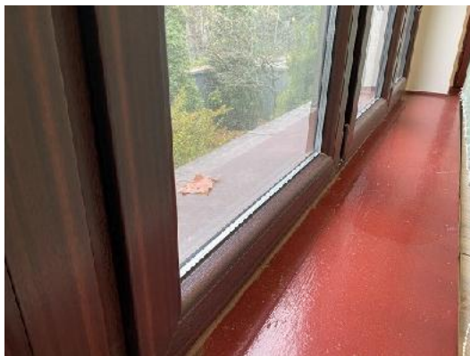
Zdj. nr 19 i 20. Jedno okno od strony frontowej na parterze oraz kilka na poddaszu wymienionych na nowe, kilka i kilkanaście lat temu. Profil PCV, przeszklenie dwuszybowe, zespolone.
