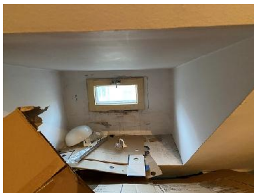
Zdj. nr 11 i 12. Stalarka okienna drewniana, jednoszybowe, stare, nieuszczelnione w budynku przy ul. Księdza Piotra Skargi 15 w Szczecinie
