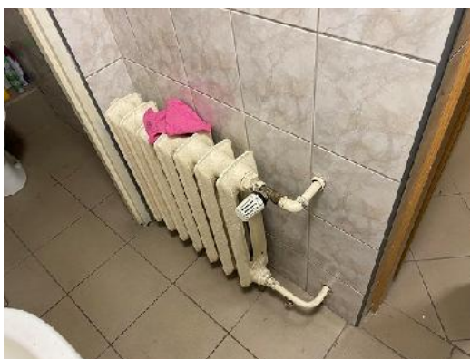
Zdj. nr 29 i 30. Wewnętrzna instalacja c.o. w budynku kilkudziesięcioletnia, wodna, zamknięta, pompowa z grzejnikami stalowymi, płytowymi i żeliwnymi, członowymi, w większości z zaworami i głowicami termostatycznymi. Instalacja wykonana z rur stalowych oraz miedzianych.
