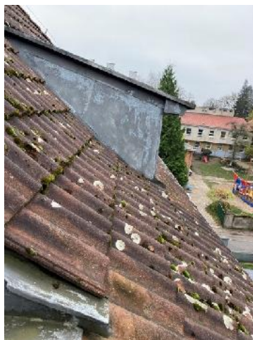
Zdj. nr 21 i 22. Widoczny taras od strony wschodniej oraz poszycie dachu stromego z dachówki cementowej. Obróbki blacharskie, ściany lukarn oraz kominy ponad dachem w złym stanie technicznym w budynku PUM przy ul. Księdza Piotra Skargi 15 w Szczecinie. Od kominów odspaja się tynk. Rynny nieszczelne. Ściany lukarn pokryte blachą, przybitą gwoździami. Dachówka zarośnięta mchem i glonami.
