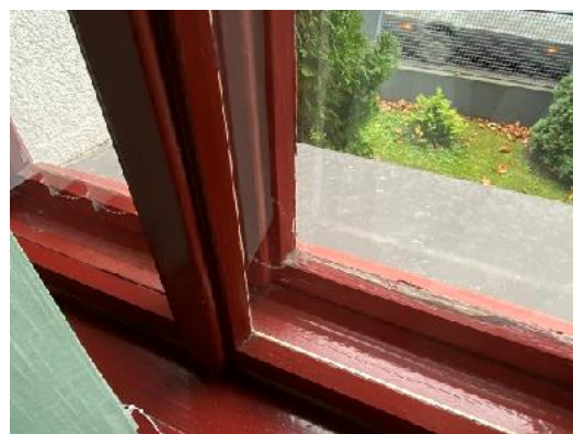
Zdj. nr 17 i 18. W większości w budynku stolarka okienna drewniana, skrzynkowa, dwuszybowa, stara, nieszczelna.
