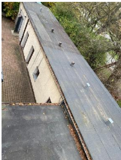
Zdj. nr 9 i 10. Stropodach przybudówki pokryty papą, budynku przy ul. Księdza Piotra Skargi 15 w Szczecinie. Stolarstwo drzwiowe drewniane, klepkowe, stare, nieuszczelnione, nieocieplone.
