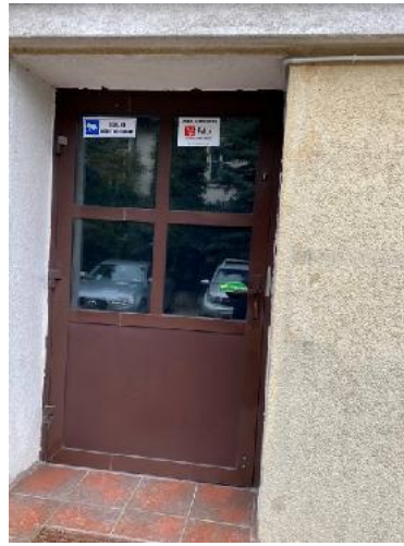
Zdj. nr 13 i 14. Stolarka drzwiowa frontowa i tylna na profilach aluminiowych, z przeszkleniem dwuszybowym, kiludziesięcioletnia, nieszczelna, nieocieplona.
