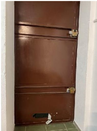
Zdj. nr 15 i 16. Stolarka drzwiowa frontowa przybudówki na profilach aluminiowych, z przeszkleniem dwuszybowym, kiludziesięcioletnia, nieszczelna, nieocieplona. Do węzła ciepłego stolarka drzwiowa na profilach stalowych, pokryta blachą, nieocieplona, nieszczelna.
