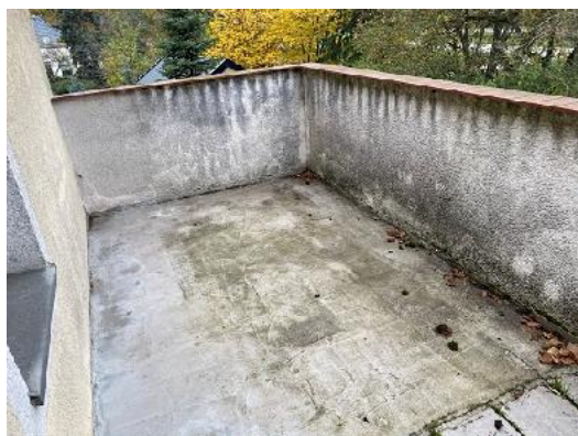
Zdj. nr 23 i 24. Taras na pomieszczeniach parteru, w złym stanie technicznym. Niedocieplony, nieszczelny w budynku PUM przy ul. Księdza Piotra Skargi 15 w Szczecinie.
