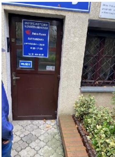
Zdj. nr 15 i 16. Stolarka drzwiowa frontowa przybudówki na profilach aluminiowych, z przeszkleniem dwuszybowym, kiludziesięcioletnia, nieszczelna, nieocieplona. Do węzła ciepłego stolarka drzwiowa na profilach stalowych, pokryta blachą, nieocieplona, nieszczelna.
