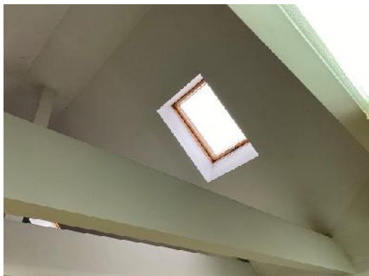
Zdj. nr 25 i 26. Dach nad użytkowym poddaszem z oknami połaciowymi, wykończony płytami GK.
