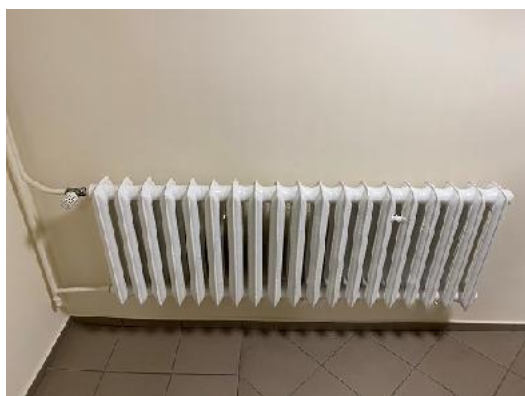
Zdj. nr 29 i 30. Wewnętrzna instalacja c.o. w budynku kilkudziesięcioletnia, wodna, zamknięta, pompowa z grzejnikami stalowymi, płytowymi i żeliwnymi, członowymi, w większości z zaworami i głowicami termostatycznymi. Instalacja wykonana z rur stalowych oraz miedzianych.
