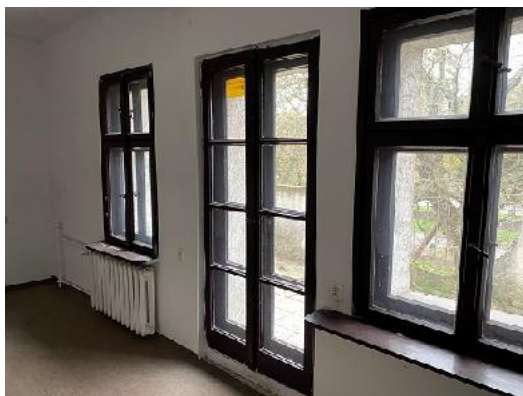
Zdj. nr 17 i 18. W większości w budynku stolarka okienna drewniana, skrzynkowa, dwuszybowa, stara, nieszczelna.
