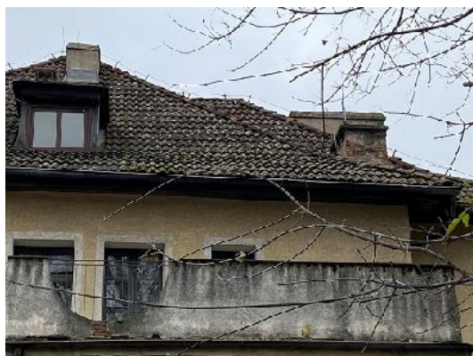
Zdj. nr 21 i 22. Widoczny taras od strony wschodniej oraz poszycie dachu stromego z dachówki cementowej. Obróbki blacharskie, ściany lukarn oraz kominy ponad dachem w złym stanie technicznym w budynku PUM przy ul. Księdza Piotra Skargi 15 w Szczecinie. Od kominów odspaja się tynk. Rynny nieszczelne. Ściany lukarn pokryte blachą, przybitą gwoździami. Dachówka zarośnięta mchem i glonami.
