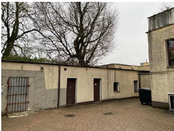
Zdj. nr 7 i 8. Elewacja przybudówki budynku przy ul. Księdza Piotra Skargi 15 w Szczecinie. Widoczne ślady zalewania elewacji spowodowane nieuszczelną rynną.
