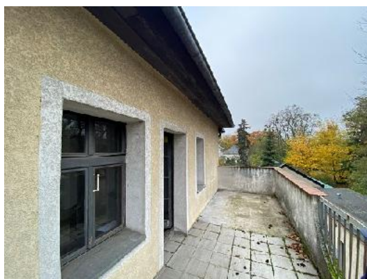
Zdj. nr 23 i 24. Taras na pomieszczeniach parteru, w złym stanie technicznym. Niedocieplony, nieszczelny w budynku PUM przy ul. Księdza Piotra Skargi 15 w Szczecinie.
