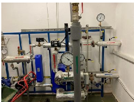
Zdj. nr 27 i 28. Węzeł cieplny dwufunkcyjny z 2018 roku, zlokalizowany w pomieszczeniu piwnicznym budynku. Jest własnością sprzedawcy ciepła i jest obsługiwany przez SEC Sp. z o.o. Budynek został podłączony do sieci ciepłowniczej miejskiej w 2018 roku.
