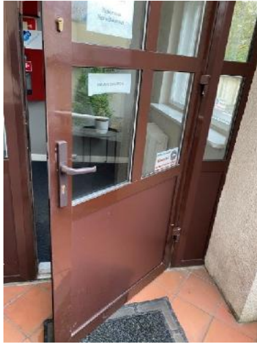
Zdj. nr 13 i 14. Stolarka drzwiowa frontowa i tylna na profilach aluminiowych, z przeszkleniem dwuszybowym, kiludziesięcioletnia, nieszczelna, nieocieplona.
