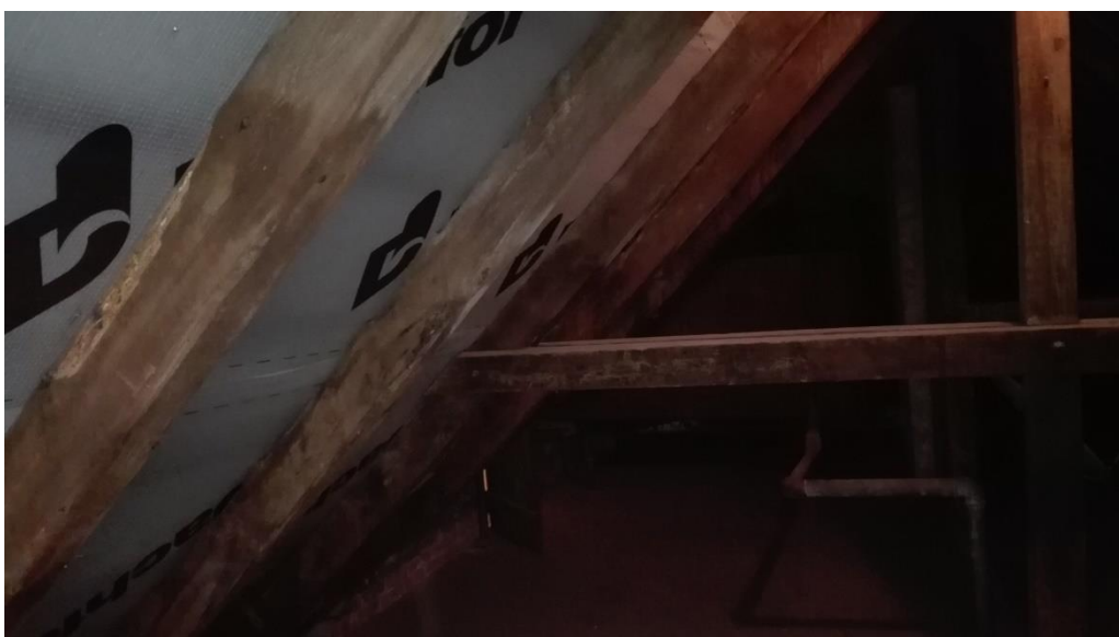
Fot. 10 – Więźba dachowa – Widoczne ubytki w krowki.
