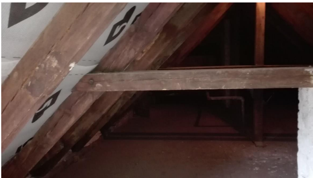
Fot. 9 – Więźba dachowa – Widoczne rozwarstwienie krowki.
