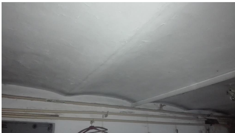
Fot. 1 – Strop Kleina nad piwnicami przeznaczony do wyburzenia.
