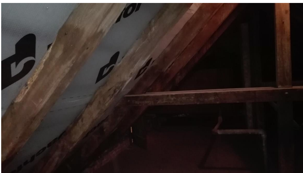
Fot. 10 – Więźba dachowa – Widoczne ubytki w krowki.
