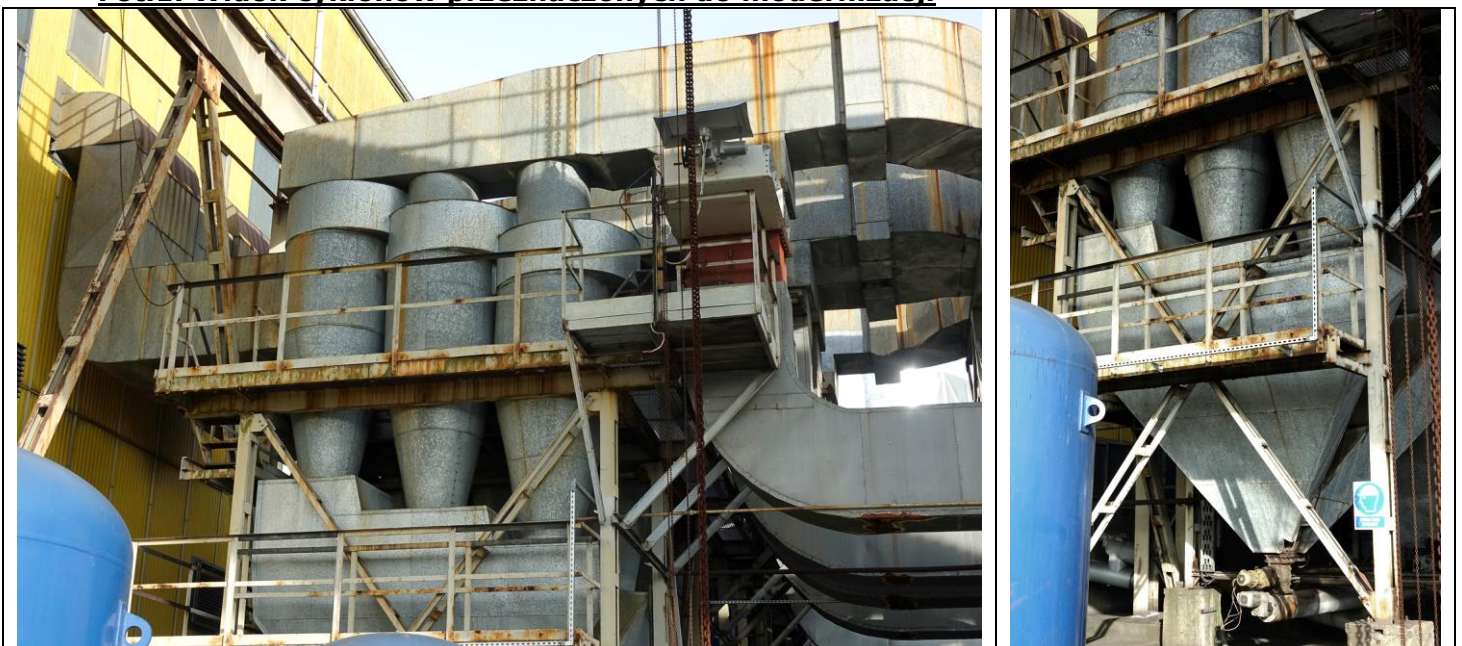
Fot.1. Widok cyklonów przeznaczonych do modernizacji
