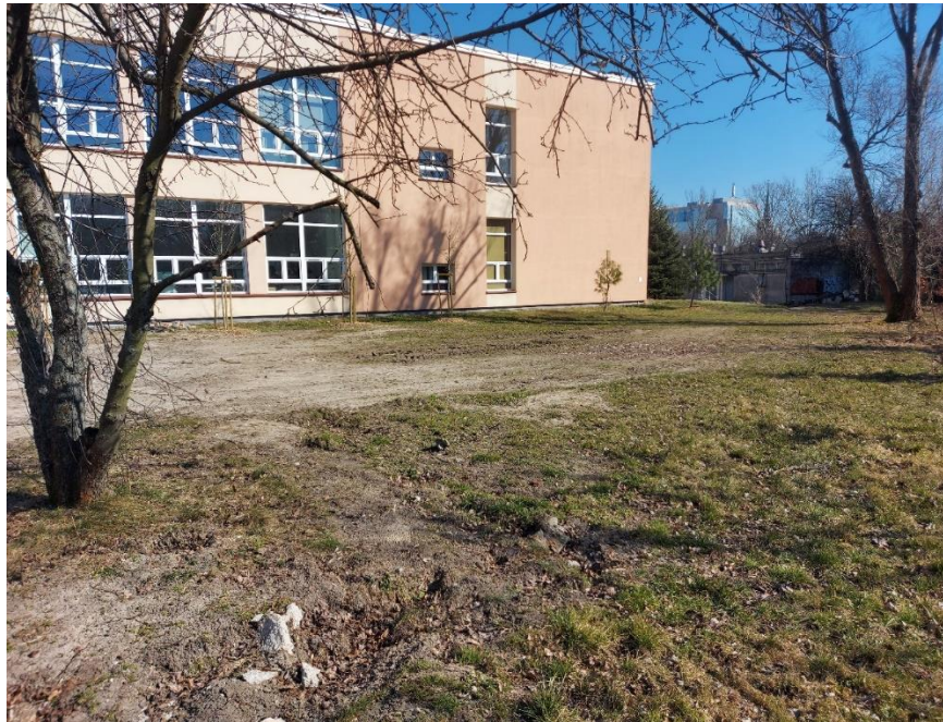
Rysunek 4 Aktualny widok terenu przeznaczonego do rewitalizacji
